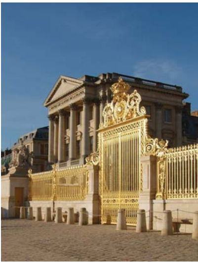
Le pavillon Dufour avant travaux © chateau de Versailles, C. Milet
