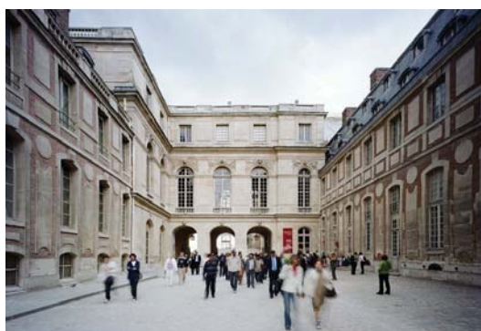
La cour des Princes, avant travaux, décembre 2013 © Patrick Tourneboeuf - Oppic - Décembre 2013
