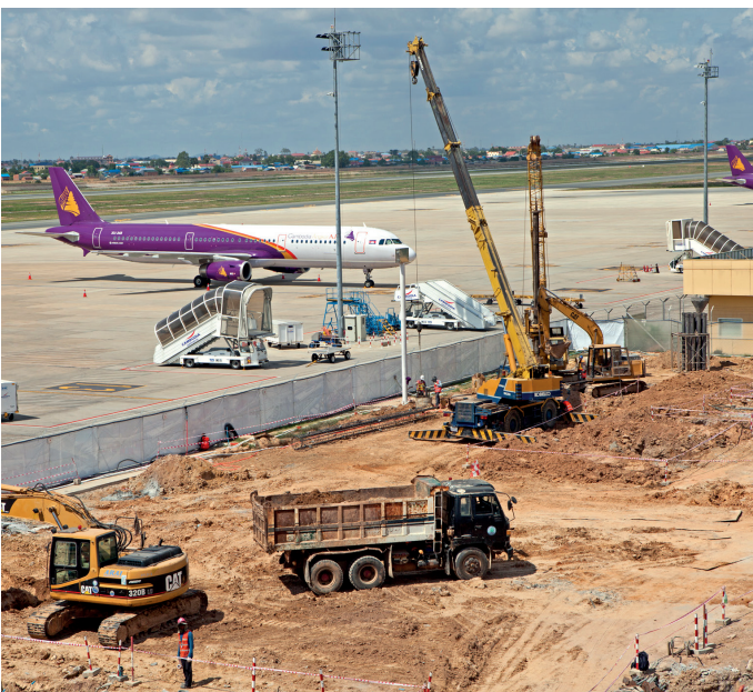
1. Forage des pieux au pied des pistes à Phnom Penh.
