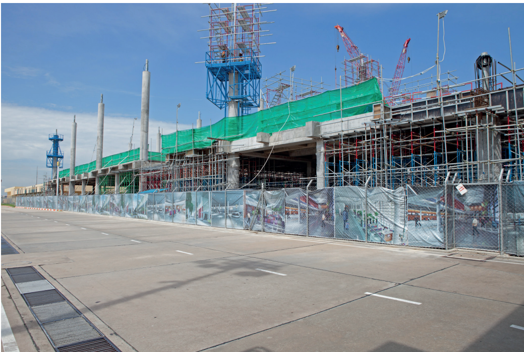
Vue du coffrage grimpant au pied des pistes à Phnom Penh.
