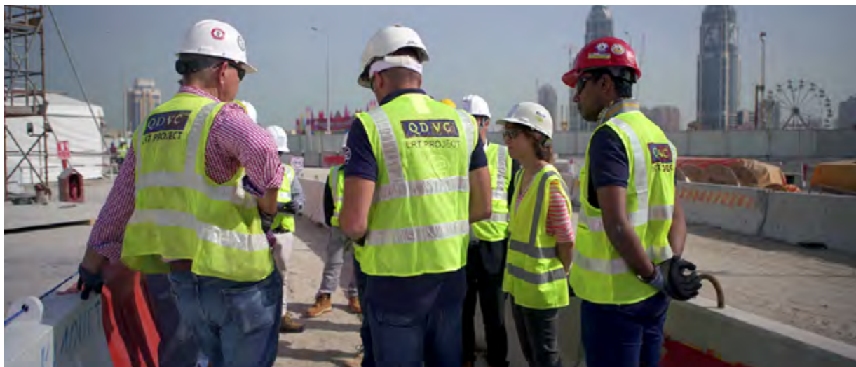
Visite du site de la station Pearl du projet LRT de Lusail.
