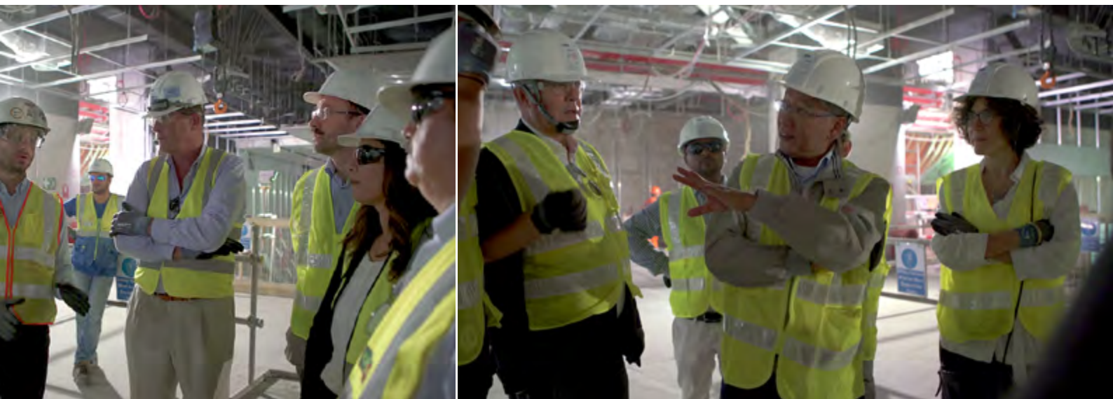
Visite du site de la station Pearl du projet LRT de Lusail.
