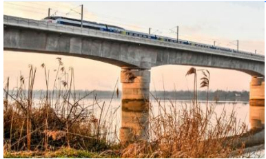
Infrastructures ferroviaires pour une mobilité bas carbone
