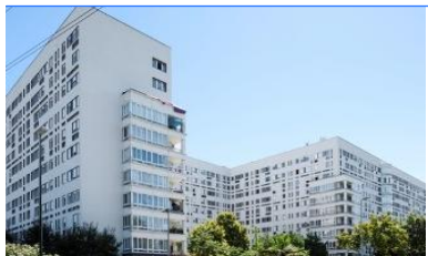
Réhabilitation du bâti
