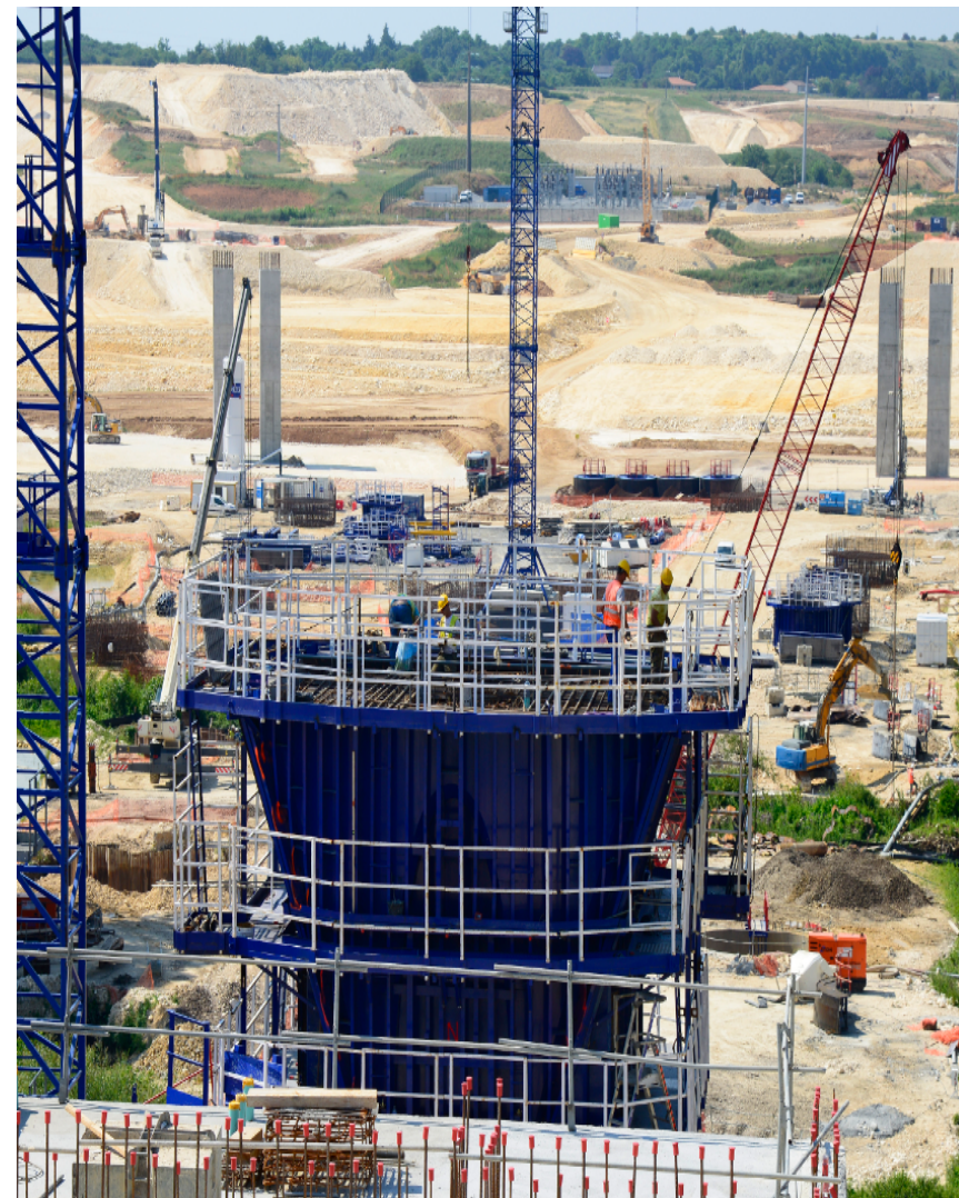
Chantier de la LGV Tours-Bordeaux : construction des viaducs de l'Auxance
