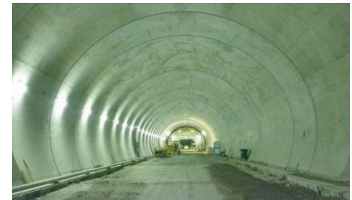
Chantier de la section autoroutière Maliakos-Kleidi en Grèce
