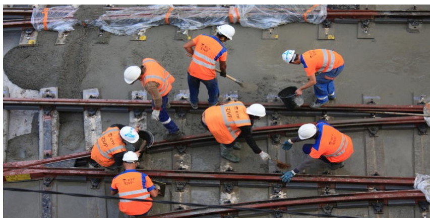
Travaux du tramway de Dijon
