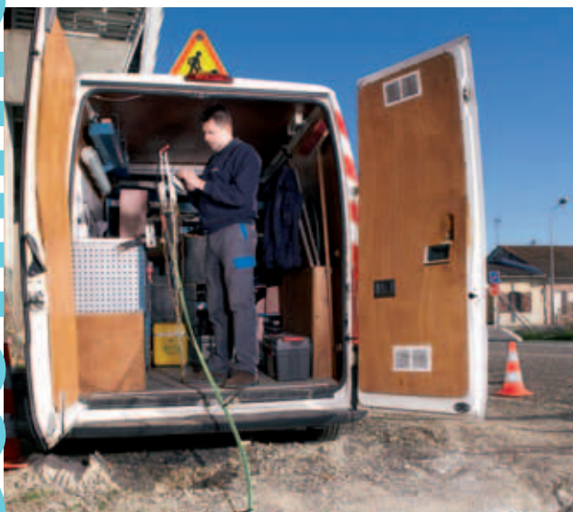
>>> Déploiement de fibre optique près de Bordeaux pour le compte de l'opérateur Neuf Cegetel.
