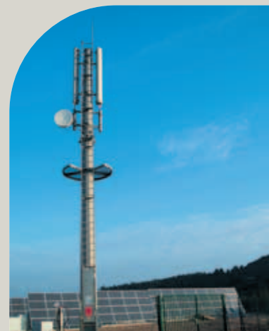
Antenne radio alimentée par panneaux solaires (réalisation Graniou pour SFR)
