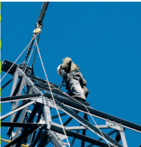
>>> Travaux sur la ligne haute tension 400 kV Albertville-Cornier.
