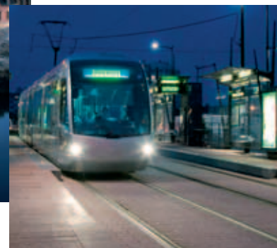
>>> Éclairage public pour le tramway de Valenciennes, inauguré en juin 2006.
