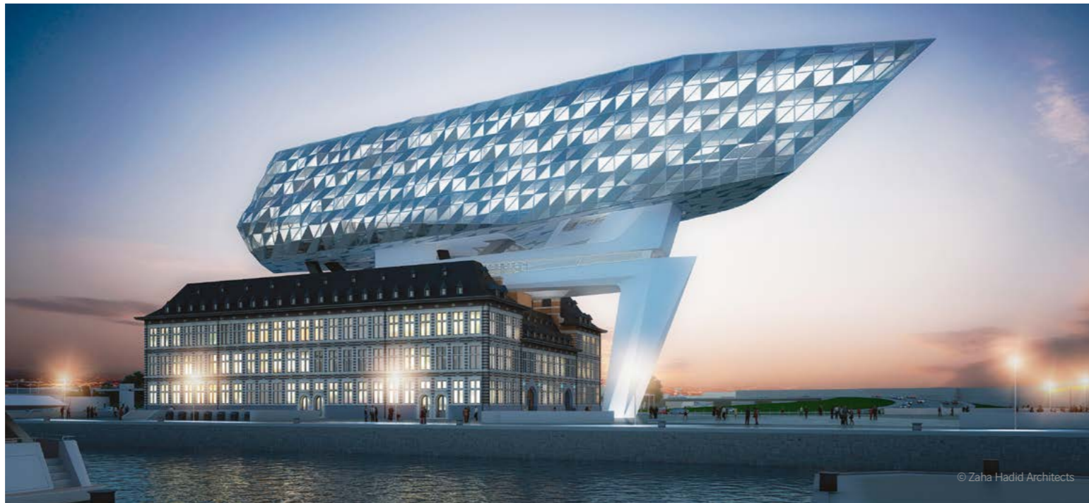
Plusieurs entreprises de VINCI Energies ont participé à la rénovation de la Maison du Port à Anvers (Belgique).
