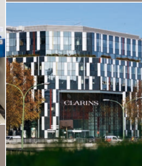
▶ Facility management pour Clarins à Paris (France).
