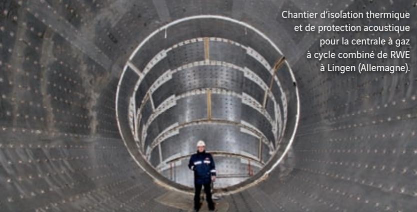
Chantier d'isolation thermique et de protection acoustique pour la centrale à gaz à cycle combiné de RWE à Lingen (Allemagne).
