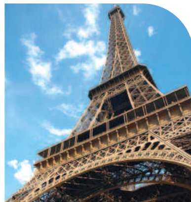
Prestations multitechniques pour la tour Eiffel - Paris.
