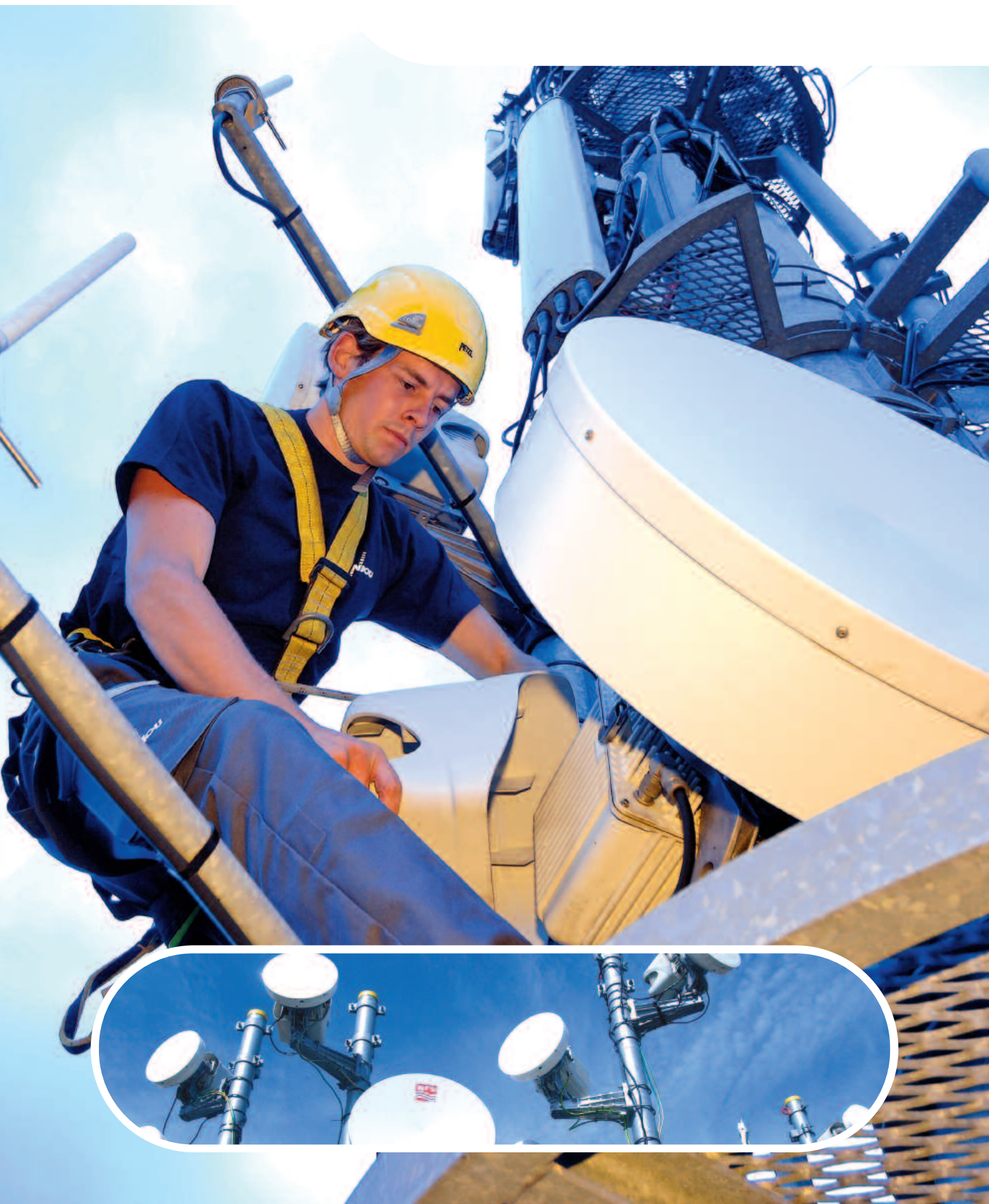
●●● Installation de Faisceaux Hertzien (FH) à Saint-Étienne de Villars / Installation de FH en région parisienne (vue générale).
