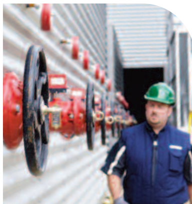
Protection incendie pour Cogesal-Miko, Saint-Dizier - Haute-Marne.
