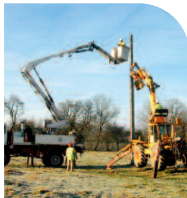
Effacements de réseaux et travaux aériens, SDEC Énergie - Calvados.
