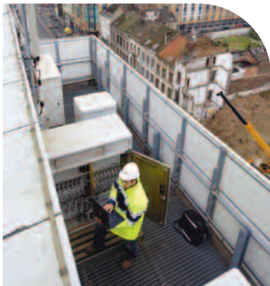
Swap baies radio pour l'équipementier Nortel - Belgique.
