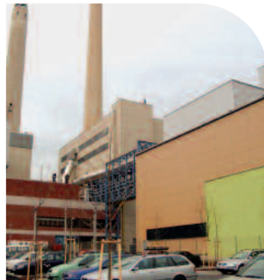
Contrôle commande de la centrale biomasse de HKW Pforzheim - Allemagne.
