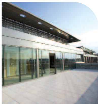
Génie électrique et climatique pour l'immeuble Grand Horizon - Marseille.
