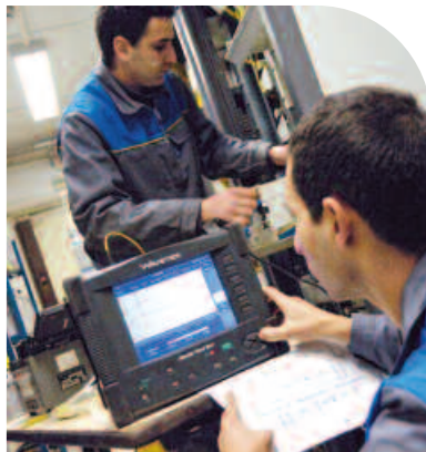
Création de boucles optiques pour Neuf Cegetel - Île-de-France.
