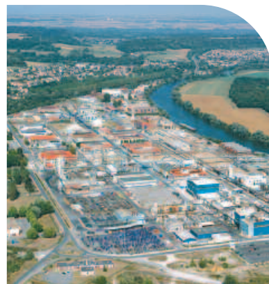
Maintenance pour la plate-forme chimique de Villers-Saint-Paul - Oise.
