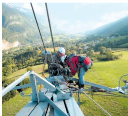
Réalisation pour RTE de la ligne 2 x 400 000 volts reliant le poste de Chaffard au poste de Grande-Ile (France). Le projet représente 353 km de câbles et 1756 tonnes de superstructures.
