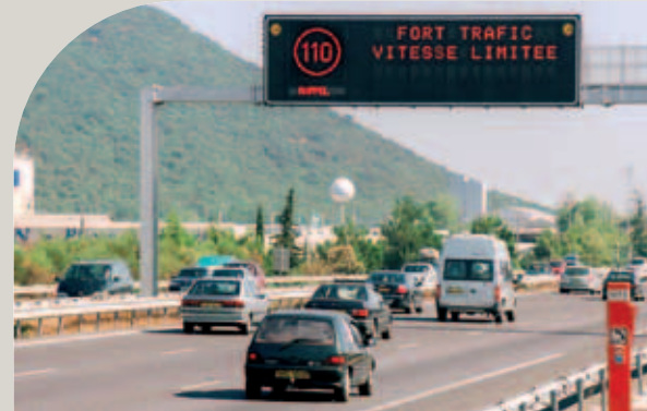
Auf der A7 zwischen Orange und Vienne (Südfrankreich) wurde vom Autobahnbetreiber ASF nach Beratung durch VINCI Energies ein Verkehrsbeeinflussungssystem installiert.
