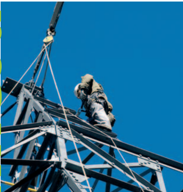
>>> Arbeiten an der 400 kV-Hochspannungsleitung Albertville-Cornier (französische Alpen).
