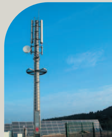
Über Solarzellen gespeiste Mobilfunkantenne (Graniou-Projekt für SFR).
