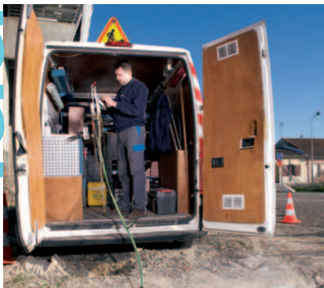
>>> Verlegung von Glasfaserleitungen bei Bordeaux im Auftrag des Netzbetreibers Neuf Cegetel.
