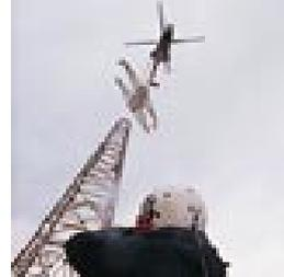
Levage de pylône par hélicoptère et déroulage sous tension mécanique d'une ligne Très Haute Tension dans les Vosges.
