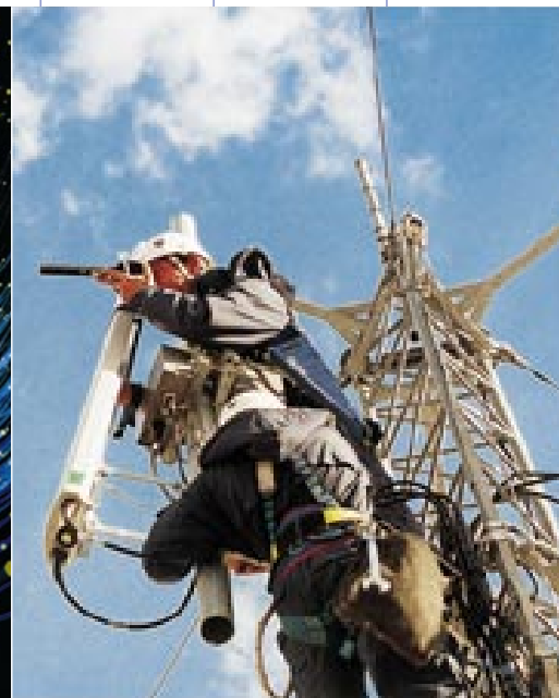
▲ Pose d'antenne SFR
