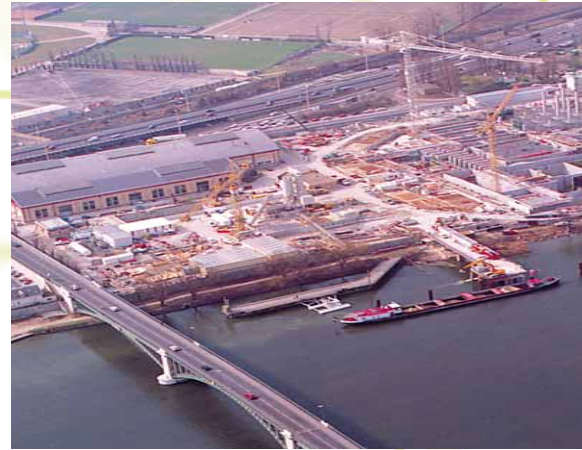
Station d'épuration de Colombes.
