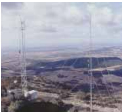
Installation de relais de radiocommunications du réseau SFR.
