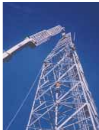
Pose antenne SFR.
