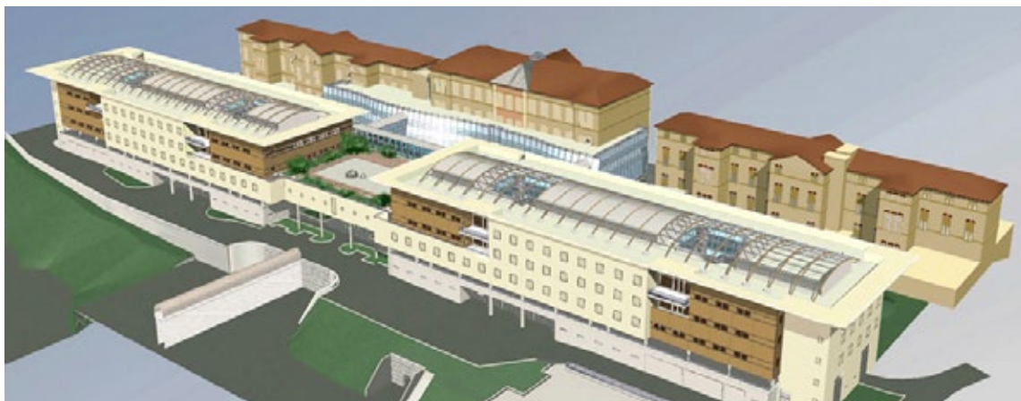
Le pavillon médical de l'hôpital Lyon Sud : un projet emblématique pour Cegelec.
