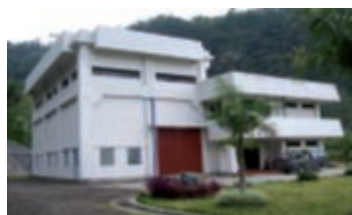
MINI-CENTRALE HYDRAULIQUE DE MALANG POUR PNL
