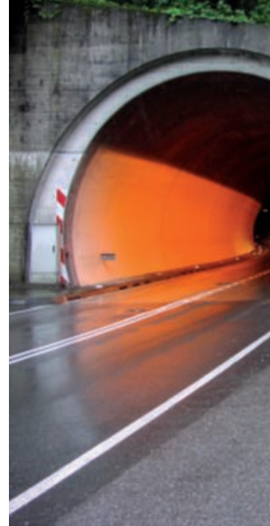
TUNNEL DE BREGENZ EN AUTRICHE
