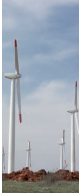
PARC ÉOLIEN SUR LE CAP DE KALIAKRA EN BULGARIE
