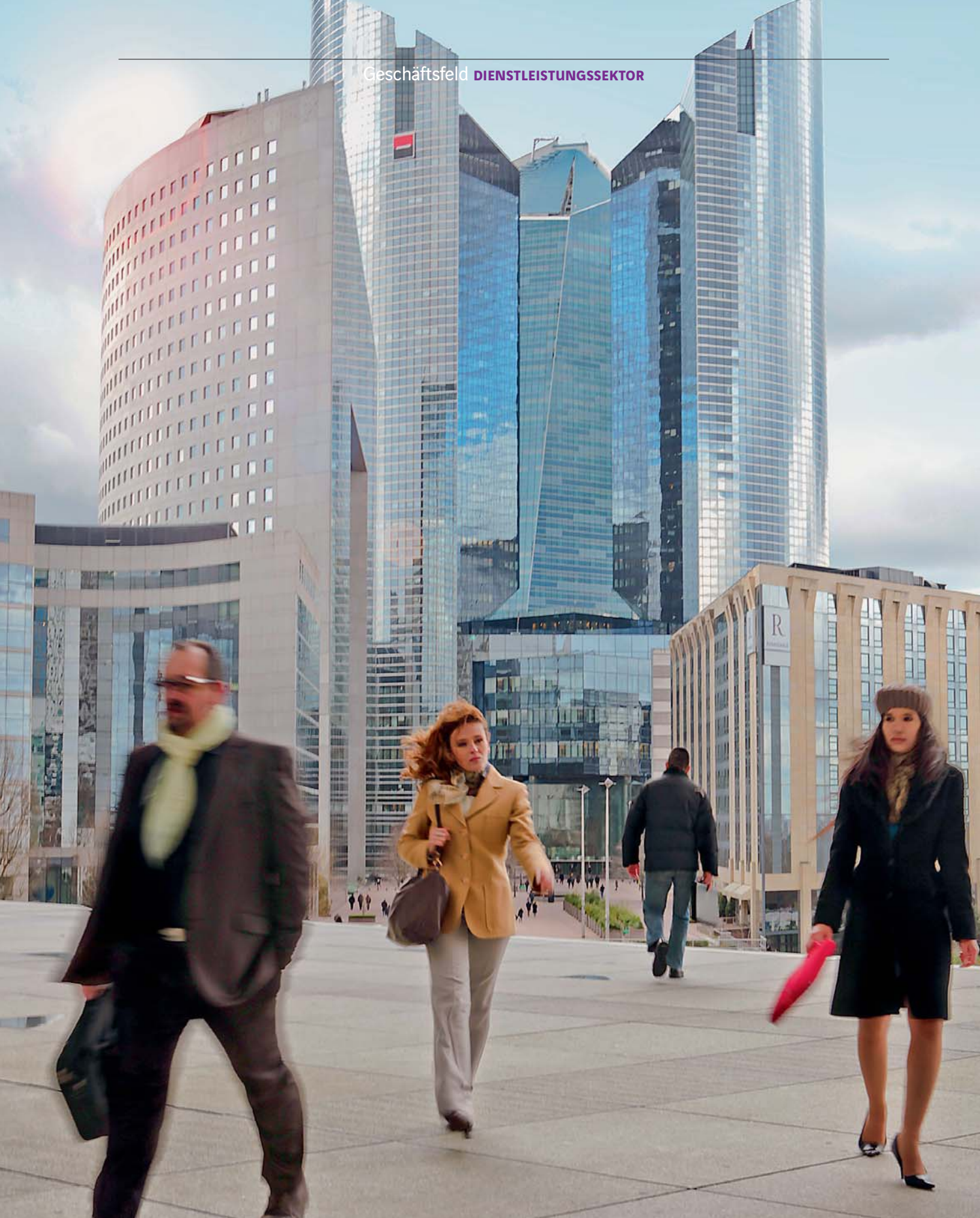
BÜROHOCHHÄUSER DER SOCIÉTÉ GÉNÉRALE IN PARIS-LA DÉFENSE (FRANKREICH). VINCI Facilities ist für das Facility Management an den Pariser Standorten La Défense und Val-de-Fontenay zuständig.
