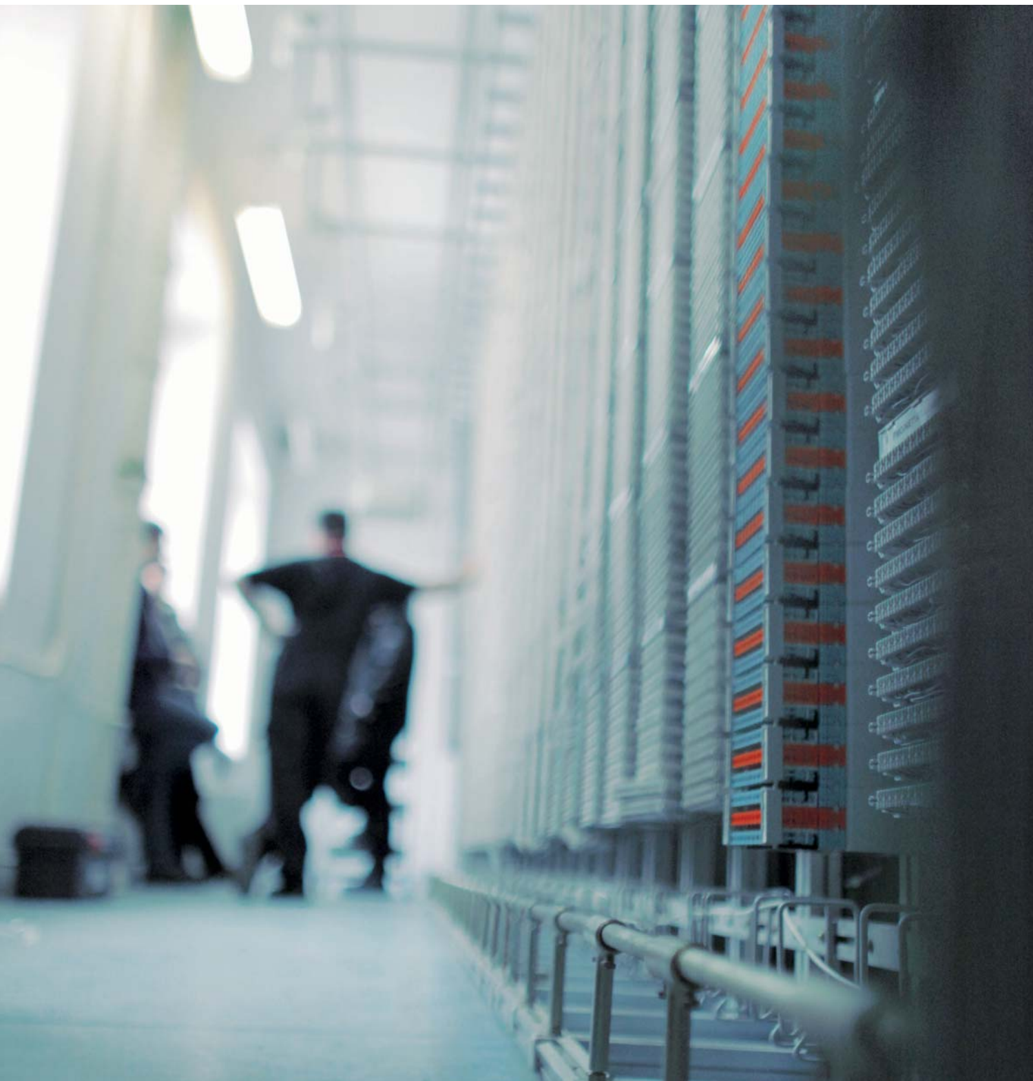
TELEFONVERMITTLUNGSSTELLE VON ORANGE POLSKA IN OPPELN (POLEN) Graniou Atem arbeitet seit mehreren Jahren mit Orange Polska am Aufbau moderner Telefonnetze in Polen.
