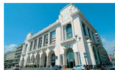
Rehabilitation of the five-star Palais de la Méditerranée hotel on the Promenade des Anglais in Nice (GTM Construction).
