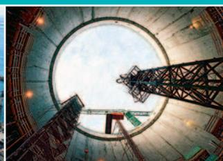
Réalisation d'un bassin enterré pour missiles de 75 m de profondeur, à Biscarosse.
