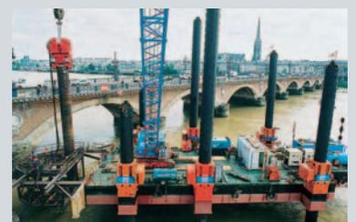
Confortement des piles du pont de Pierre, à Bordeaux (Sogea Construction).
