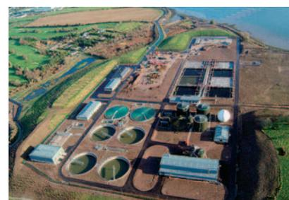
Génie civil de la station de traitement des eaux usées de Cork, en Irlande (16 réservoirs et 5 bâtiments), livrée en 2004.
