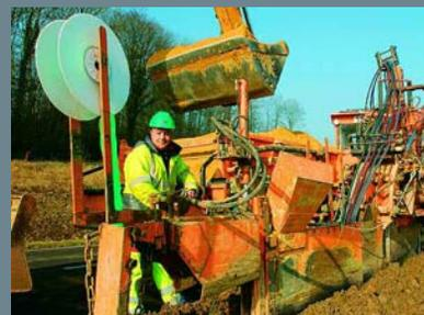
Pose mécanisée de câbles de fibres optiques. Le Groupe installe et gère des réseaux dans le cadre de délégations de service public.
