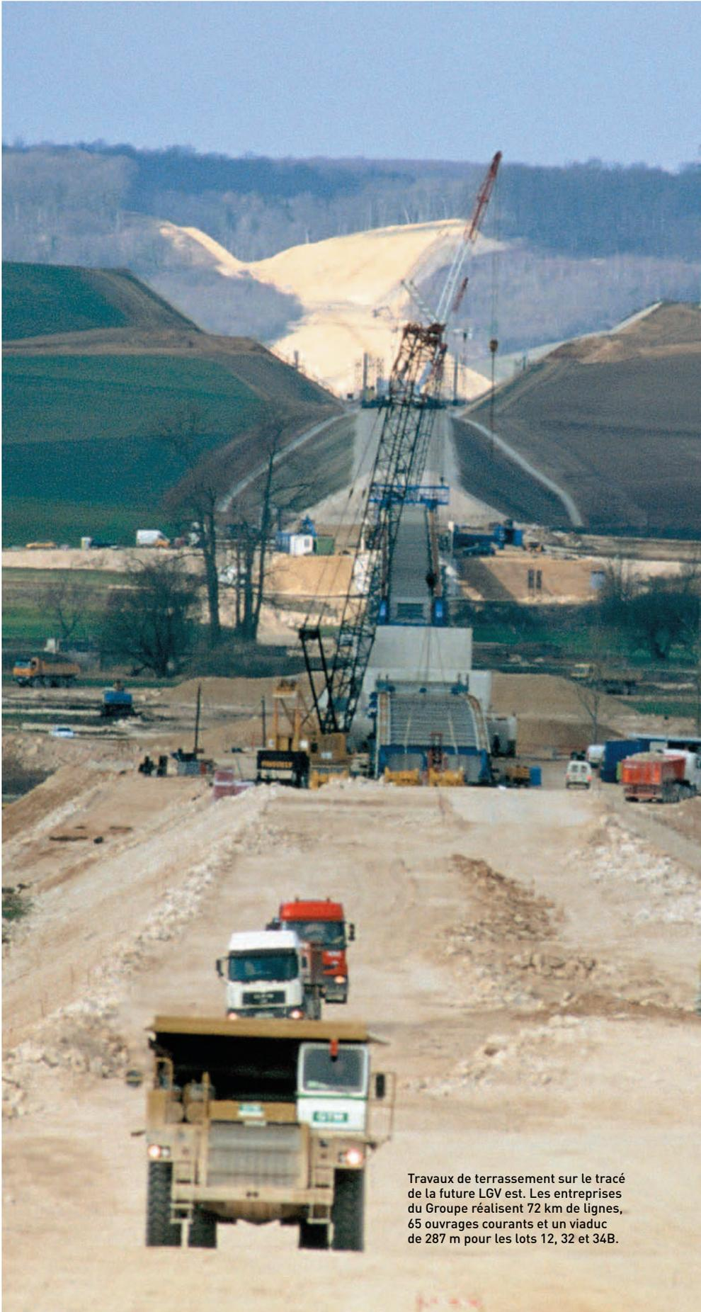
Travaux de terrassement sur le tracé de la future LGV est. Les entreprises du Groupe réalisent 72 km de lignes, 65 ouvrages courants et un viaduc de 287 m pour les lots 12, 32 et 34B.
