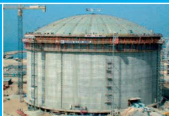
L'un des deux réservoirs de gaz naturel liquéfié d'Idku, en Egypte, d'une capacité de 140 000 m<sup>3</sup>.
