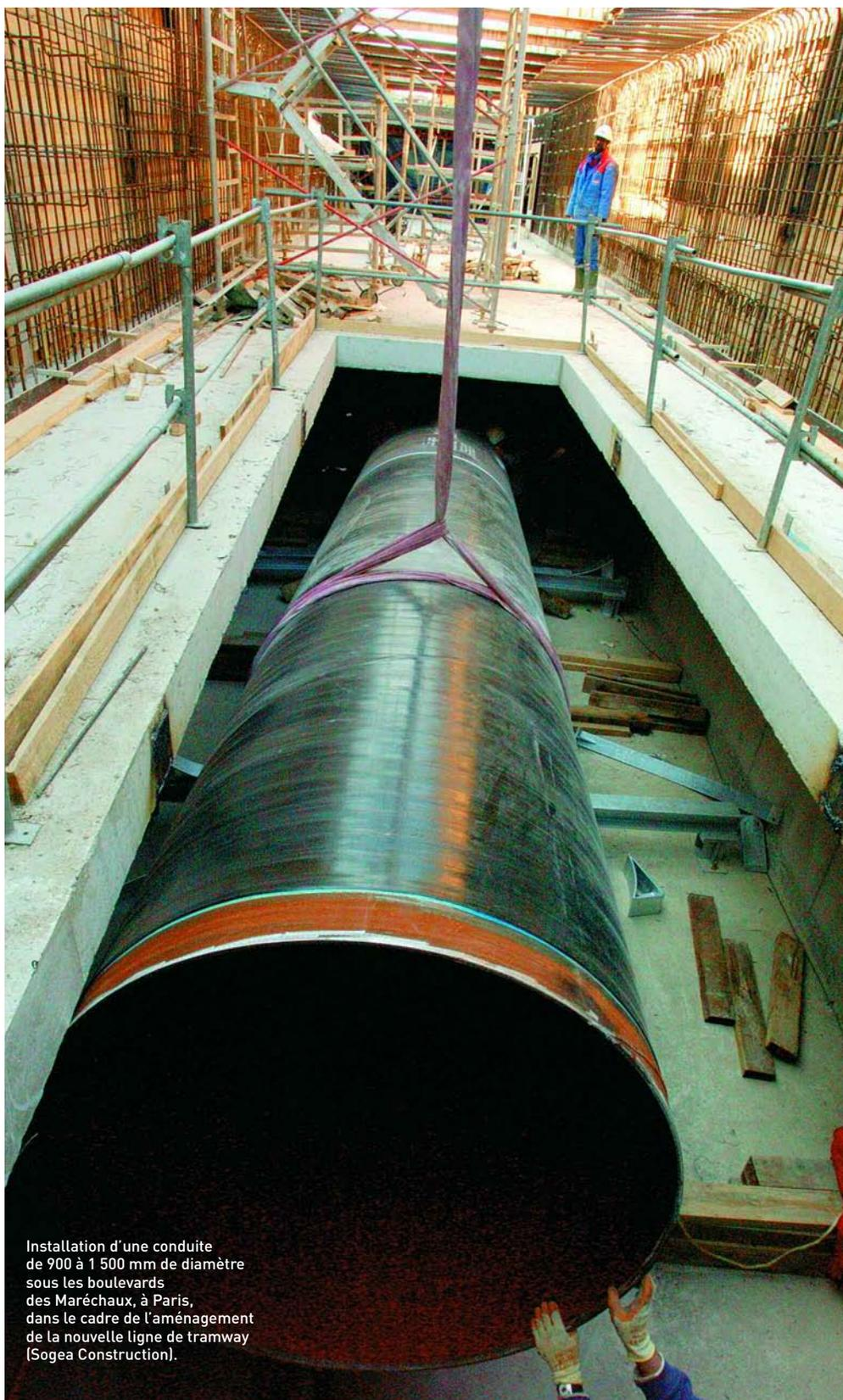
Installation d'une conduite de 900 à 1 500 mm de diamètre sous les boulevards des Maréchaux, à Paris, dans le cadre de l'aménagement de la nouvelle ligne de tramway (Sogea Construction).
