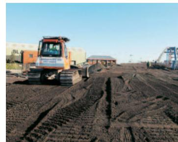
Sur le chantier du contournement routier de Newport, en Grande-Bretagne, les remblais de terrassement étaient constitués à 42 % de ballast récupéré lors de la réfection de voies ferrées.
