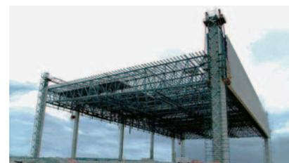
Levage à 25 m de hauteur d'une ferme de 3 000 t, coiffant un hangar de l'aéroport de Brisbane, en Australie.
