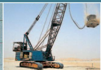
Compactage dynamique d'une plate-forme de 3,5 millions de m<sup>2</sup>, à Abu Dhabi (Ménard Soltraitement).
