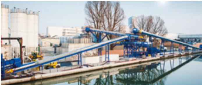
Tapis convoyeur installé pour l'évacuation des déblais par péniche, via le canal Saint-Denis, sur le chantier de la ligne 12 à Paris.
