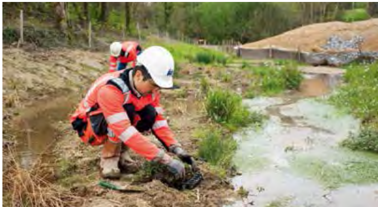
Renaturation des cours d'eau par plantations de différentes espèces végétales sur le chantier de l'A63 (dans le Sud-Ouest de la France).
