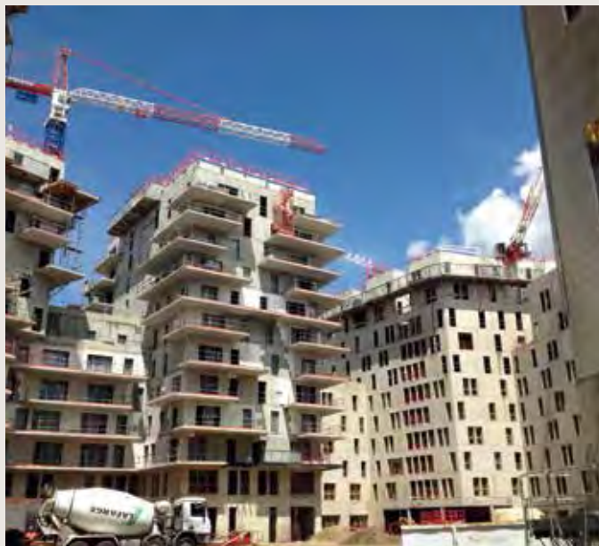
ZAC des Girondins à Lyon (France): construction de 837 logements.
