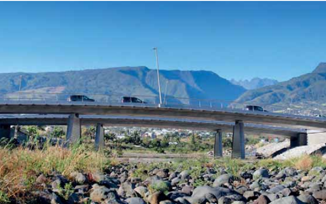
Ponts de la ravine du Chaudron // La Réunion SBTPC (VINCI Construction Dom-Tom) et Dodin Campenon Bernard ont réalisé en partenariat les deux ponts dalles précontraints sur la ravine du Chaudron. L'ouvrage permettra de fluidifier la circulation par tous les temps, y compris en période cyclonique.
