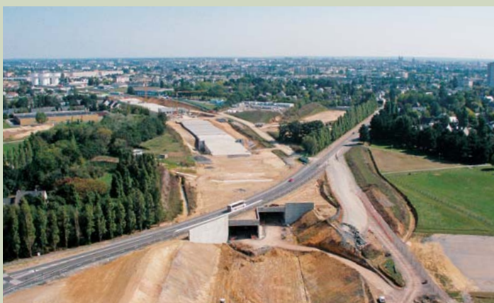
Un groupement composé majoritairement d'entreprises de VINCI Construction réalise sur l'A11, pour Cofiroute, le contournement nord d'Angers, comprenant 5 échangeurs, 16 ouvrages courants, 1 700 m de tranchée couverte et un viaduc de 530 m sur la Maine.
