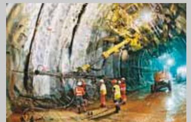
À Toulon, Solétanche Bachy participe à la construction d'un tunnel routier de 1 800 m de long, creusé à 35 m sous le centre-ville.
