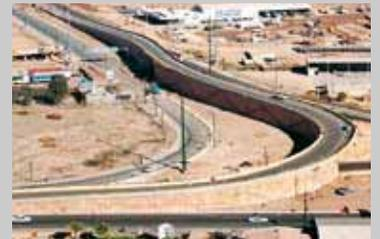
Mise en œuvre de 70 000 m<sup>2</sup> de murs en Terre Armée, par la filiale spécialisée du même nom, sur seize ouvrages d'art au Mexique.
