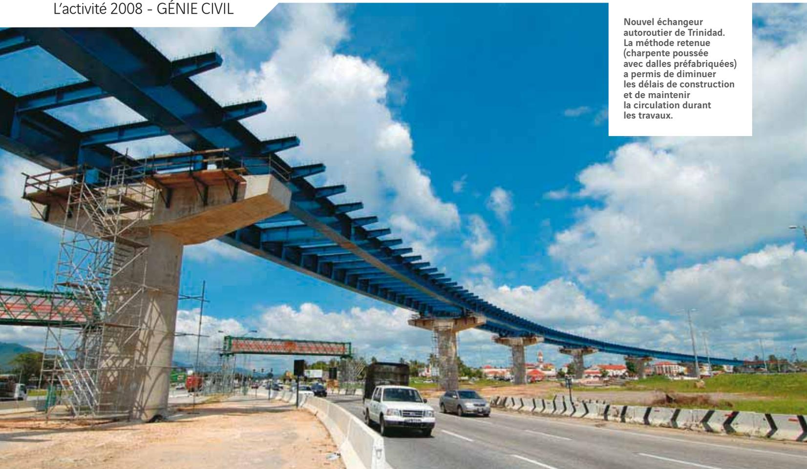
Nouvel échangeur autoroutier de Trinidad. La méthode retenue (charpente poussée avec dalles préfabriquées) a permis de diminuer les délais de construction et de maintenir la circulation durant les travaux.
