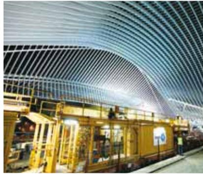
Installation de caténaies par Engema dans la nouvelle gare de Liège-Guillemins, dessinée par l'architecte Santiago Calatrava Valls.
