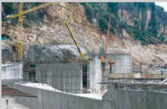
Hydroplus, filiale spécialisée dans le rehaussement de barrages, installe neuf hausses fusibles sur celui de Dafnozouara, en Grèce.
