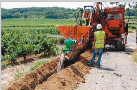
Pose de câble à fibres optiques, dans le cadre du déploiement du réseau télécoms haut débit du département de l'Hérault, en France.
