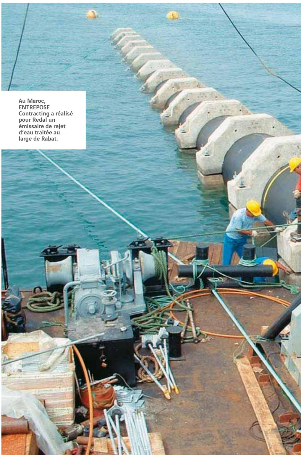
Au Maroc, ENTREPOSE Contracting a réalisé pour Redal un émissaire de rejet d'eau traitée au large de Rabat.
