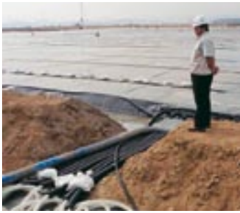
Consolidation d'une plate-forme de 295 000 m 2 dans le port de Kwang Yang, en Corée du Sud, selon le procédé Ménard Vacuum.
