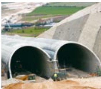
Chantier du contournement routier de Baldock (6,5 km), dans le Hertfordshire, comprenant un tunnel en tranchée couverte de 250 m.
