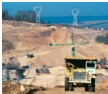
Travaux de terrassement sur la LGV est, principal chantier ferroviaire en cours en Europe (GTM Terrassement).
