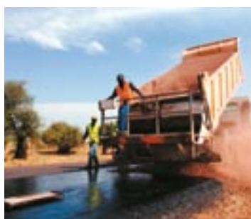
Sogea-Satom réalise en Afrique d'importants chantiers routiers au Tchad, au Kenya et en république démocratique du Congo.
