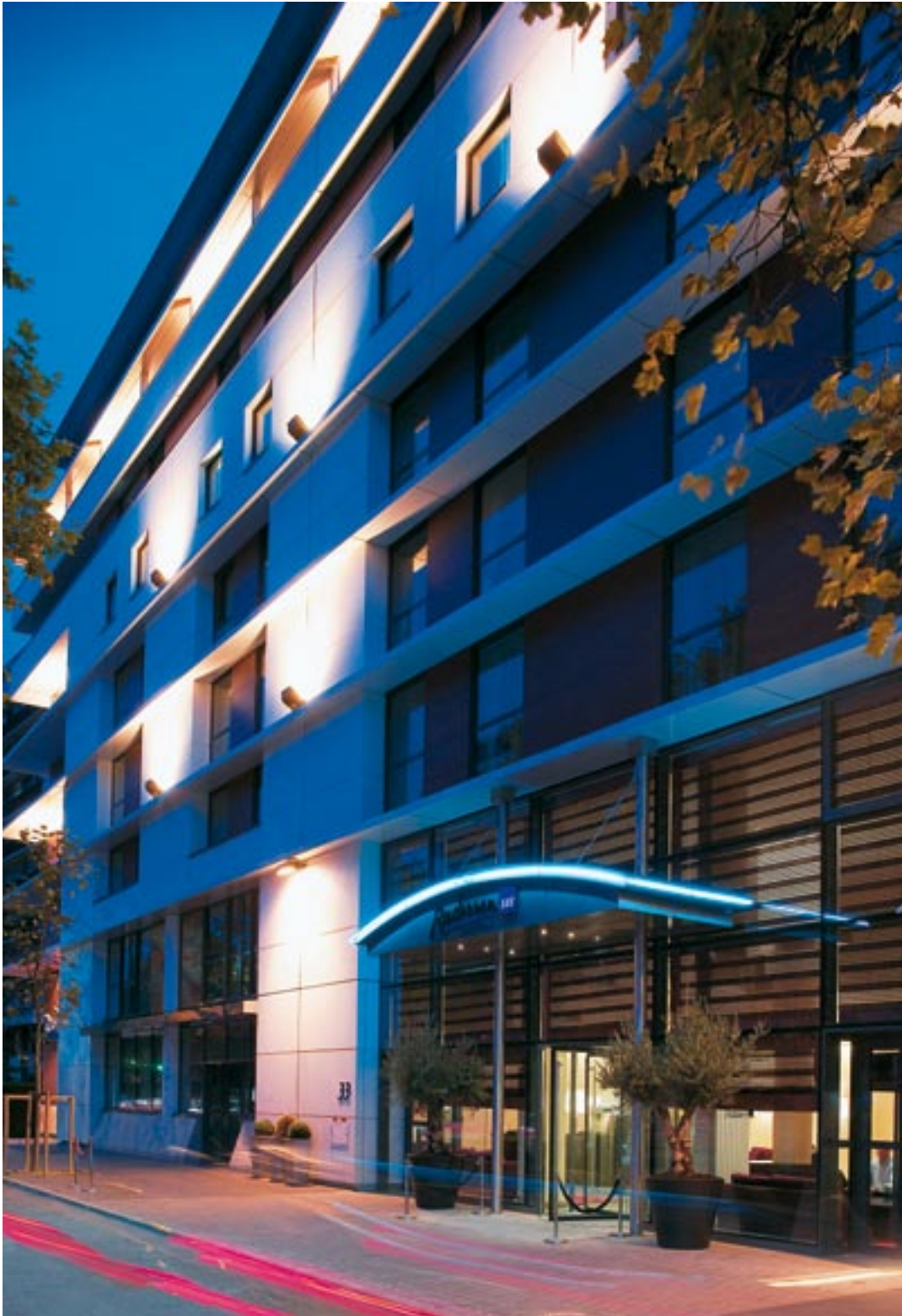
Hôtel Radisson de Boulogne-Billancourt (170 chambres) en Ile-de-France, livré en 2005 (Campenon Bernard Construction).
