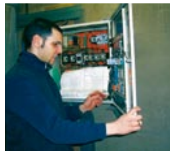
A travers la marque Manei, Sogea Construction est un acteur important de la maintenance multitechnique et multiservice de bâtiments en Ile-de-France.
