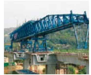
Opération de levage lourd sur le pont Shenzhen Western Corridor en Chine, que Freyssinet équipe aussi en haubans et appareils d'appui.
