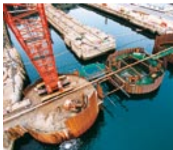
Rénovation des bassins de radoub (2 et 3) de l'arsenal de Brest (GTM Bâtiment).
