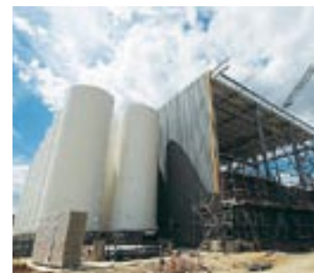
Unité de traitement des boues pour la station d'épuration de Valenton, en Ile-de-France (GTM Génie Civil et Services).
