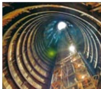
Réalisation de l'un des puits de secours de l'A86 ouest, futur tunnel à péage exploité en concession par Cofiroute en Ile-de-France.
