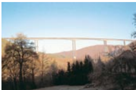
Viaduc de la Sioule (longueur, 990 m ; portée centrale, 192 m) : un ouvrage majeur sur le dernier tronçon de l'A89 reliant Clermont-Ferrand à Bordeaux.
