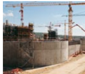
Modernisation de la station d'épuration d'Achères (Ile-de-France), dotée d'une unité de nitrification-dénitrification.
