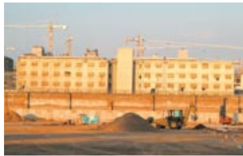
Construction de trois prisons au Chili, dans le cadre d'un partenariat public-privé incluant la gestion des sites pour une durée de 20 ans.
