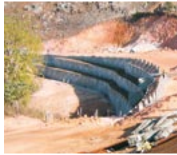
Contournement routier de Mbabane, au Swaziland, où 36 000 m 2 de Terre armée ont été mis en œuvre.
