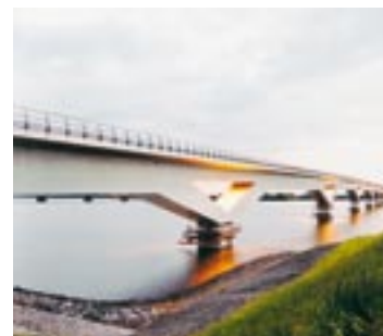
Pont de Moerdijk, sur le tracé HSL4 à Dordrecht, aux Pays-Bas.
