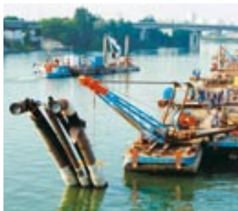
Déploiement de conduites de gaz sous la Seine, réalisé par EMCC, filiale spécialisée dans les travaux maritimes et fluviaux.
