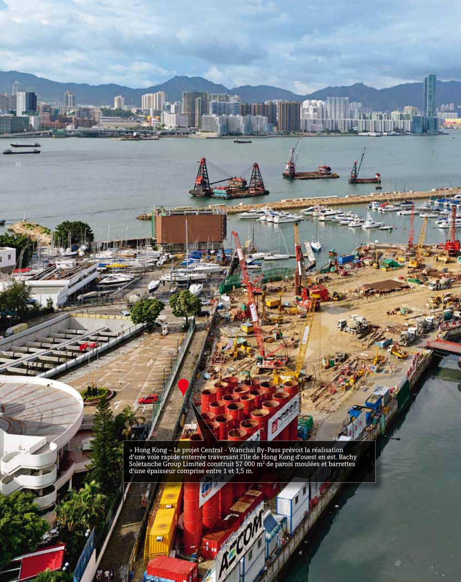
> Hong Kong – Le projet Central - Wanchai By-Pass prévoit la réalisation d'une voie rapide enterrée traversant l'île de Hong Kong d'ouest en est. Bachy Soletanche Group Limited construit 57 000 m<sup>2</sup> de parois moulées et barrettes d'une épaisseur comprise entre 1 et 1,5 m.
