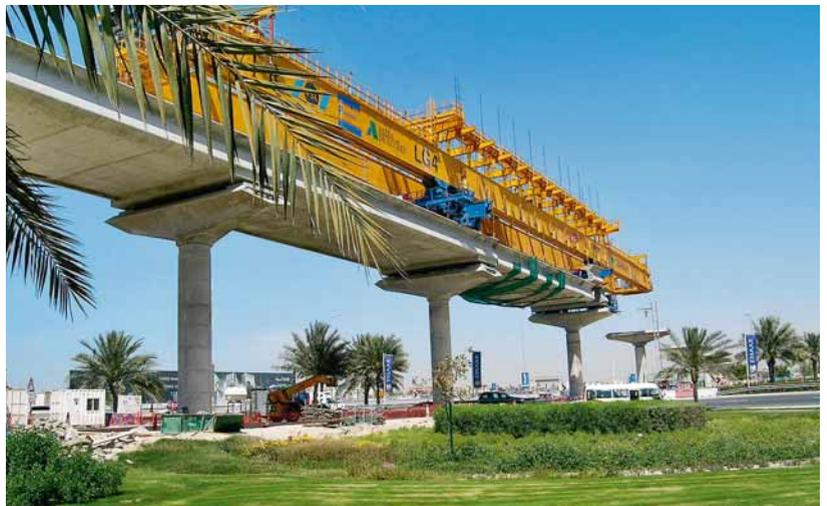
□ Appliquée à la conception et aux procédures d'utilisation des dix équipements de pose des tabliers du métro léger de Dubaï, la méthode Hazid Hazop a permis de mettre en place les 16 469 voussoirs du viaduc sans incident notable.
