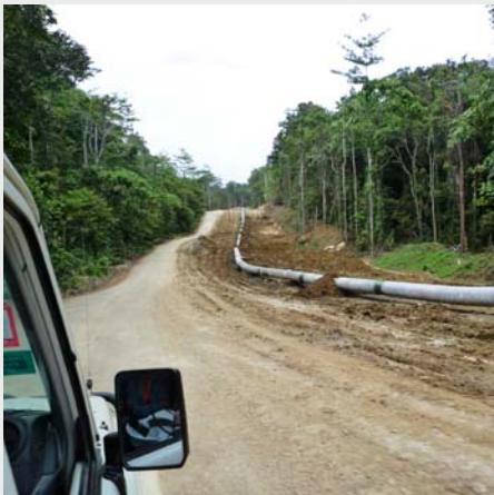
Papouasie – Nouvelle-Guinée – Restauration du sol après la pose du pipeline. Projet PNG LNG.
