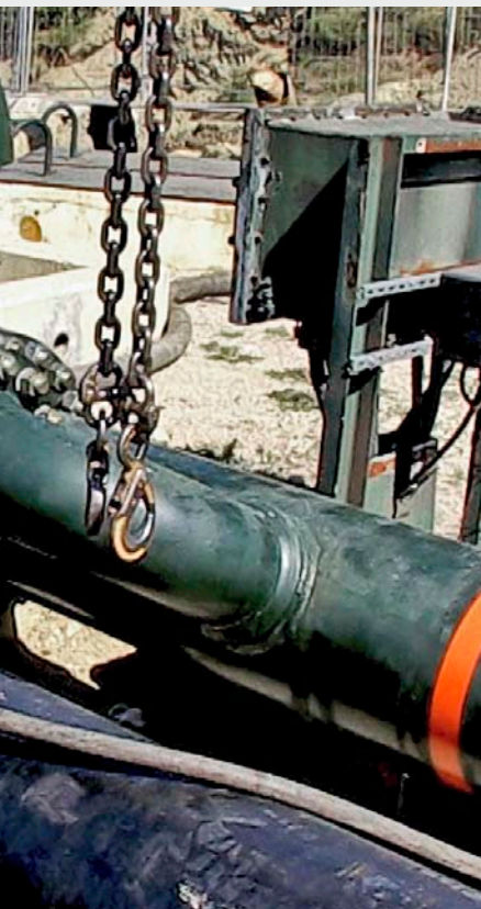
03. France – Puits d’exploitation de la cavité butane du stockage souterrain de GPL (306 000 m 3 ) en cavités minées de Geogaz, à Lavéra.
