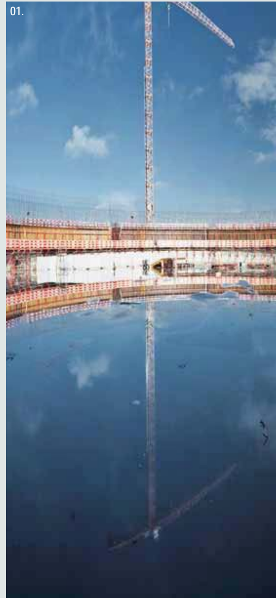
01. Construction des parois d'un réservoir cryogénique.
