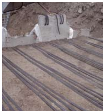
□ EcoStrap®, armadura insensible al entorno alcalino.
