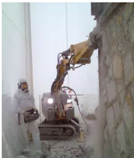
□ Operación de desmantelamiento teledirigido en el centro de la SICN (Sociedad industrial de combustible nuclear) en Annecy.
