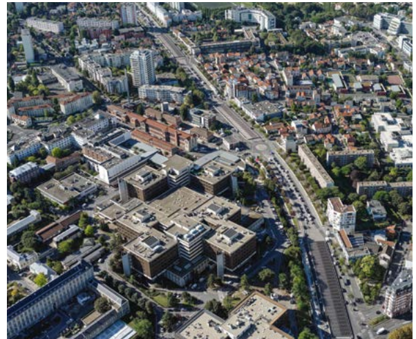
VINCI Construction obtuvo el primer lote de ingeniería civil de la prolongación de la línea 14 Sur que conectará París con el aeropuerto de Orly.
