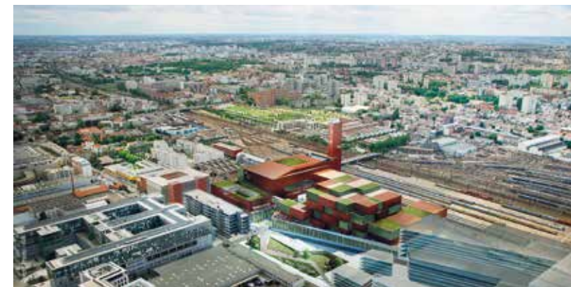
CENTRO DE APROVECHAMIENTO DE RESIDUOS DE IVRY-PARIS XIII // FRANCIA Este contrato de diseño-construcción supone un importe de 513 millones de euros a lo largo de casi 12 años para las empresas de VINCI.
