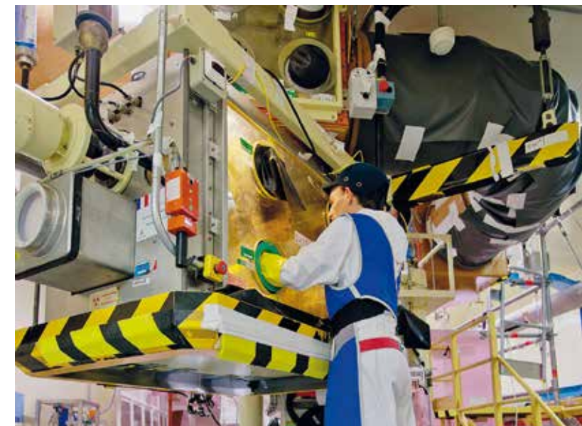
CADARACHE // FRANCIA Desmantelamiento de una caja de guantes.
