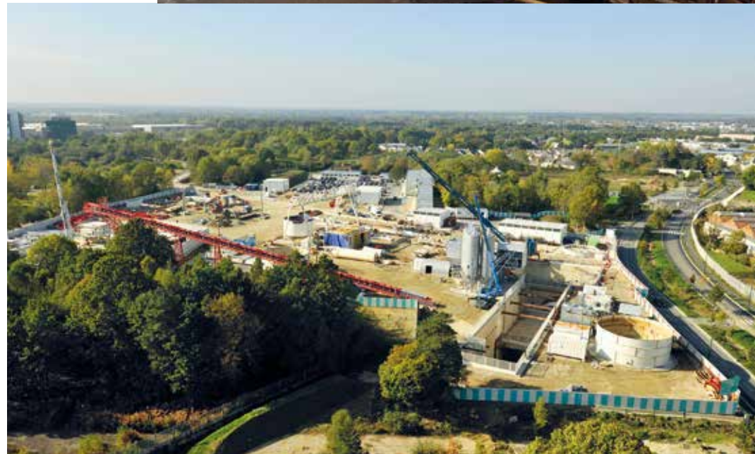
AEROPUERTO DE SIBITI // CONGO SGE-C Congo (Sogea-Satom) construye una pista de 2.050 m de longitud con capacidad para recibir al Boeing 737, una pista de rodadura, la plataforma, el aparcamiento para coches, así como una vía de acceso.
