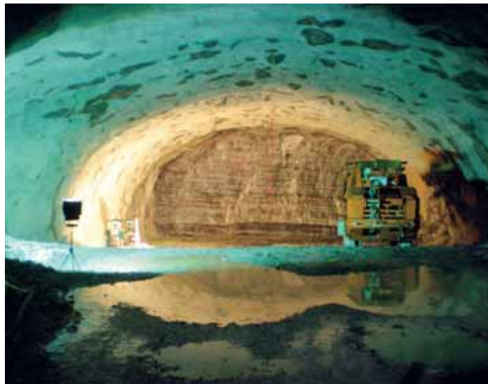
Jurong Rocks Caverns, Singapur Geostock (Entrepose Contracting) participa en la creación de la primera instalación de almacenamiento subterráneo de hidrocarburos del Sudeste Asiático en cinco grutas excavadas bajo el mar, cerca de la isla de Jurong.
