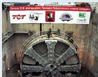
VINCI Construction Grands Projets a achevé le 20 février le creusement du tunnel routier de Lefortovo, situé sur le parcours du troisième périphérique circulaire urbain de la ville de Moscou. Ce tunnel de 2,2 km a été réalisé au tunnelier à pression de boue d'un diamètre de foration de 14,2 m, soit le plus grand tunnelier du monde en site urbain. ■
