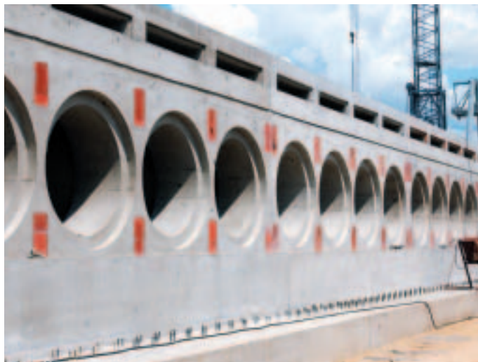
Fin 2004, quatre ans et demi après la signature du contrat, l'unité de stockage de Tchernobyl devrait être livrée au client.
