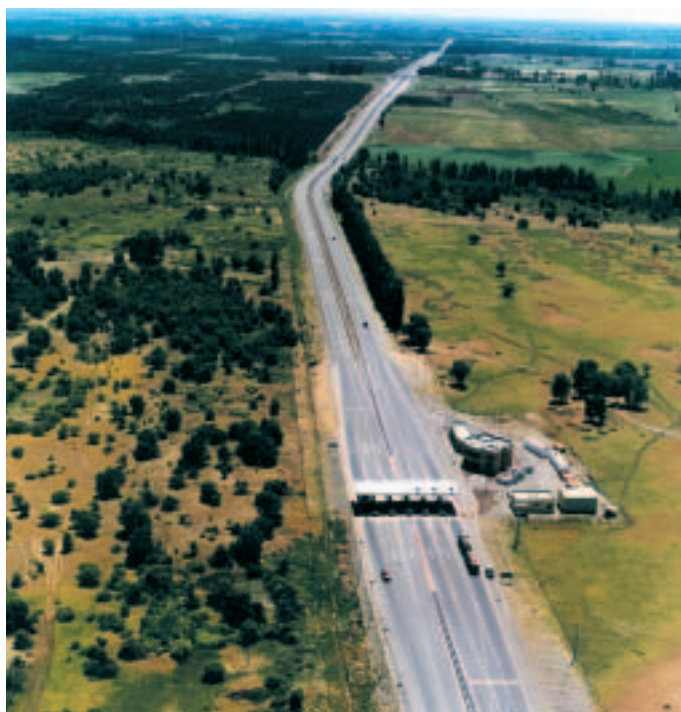
Le projet d'autoroute entre Chillan et Collipulli a nécessité la construction de 80 ouvrages d'art et de 600 ouvrages d'assainissement.
