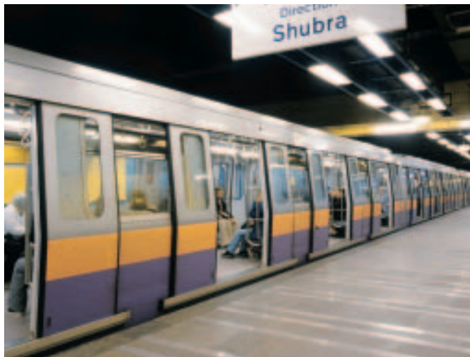
VINCI Construction Grands Projets a participé à la construction de la quasi-totalité des lignes 1 et 2 du métro du Caire.
