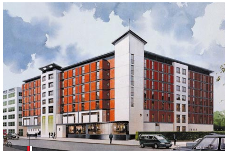
Les travaux de l'hôtel Novotel Leeds au Royaume-Uni, réalisés en conception-construction, ont débuté en octobre 2000. La livraison est prévue en avril 2002.
