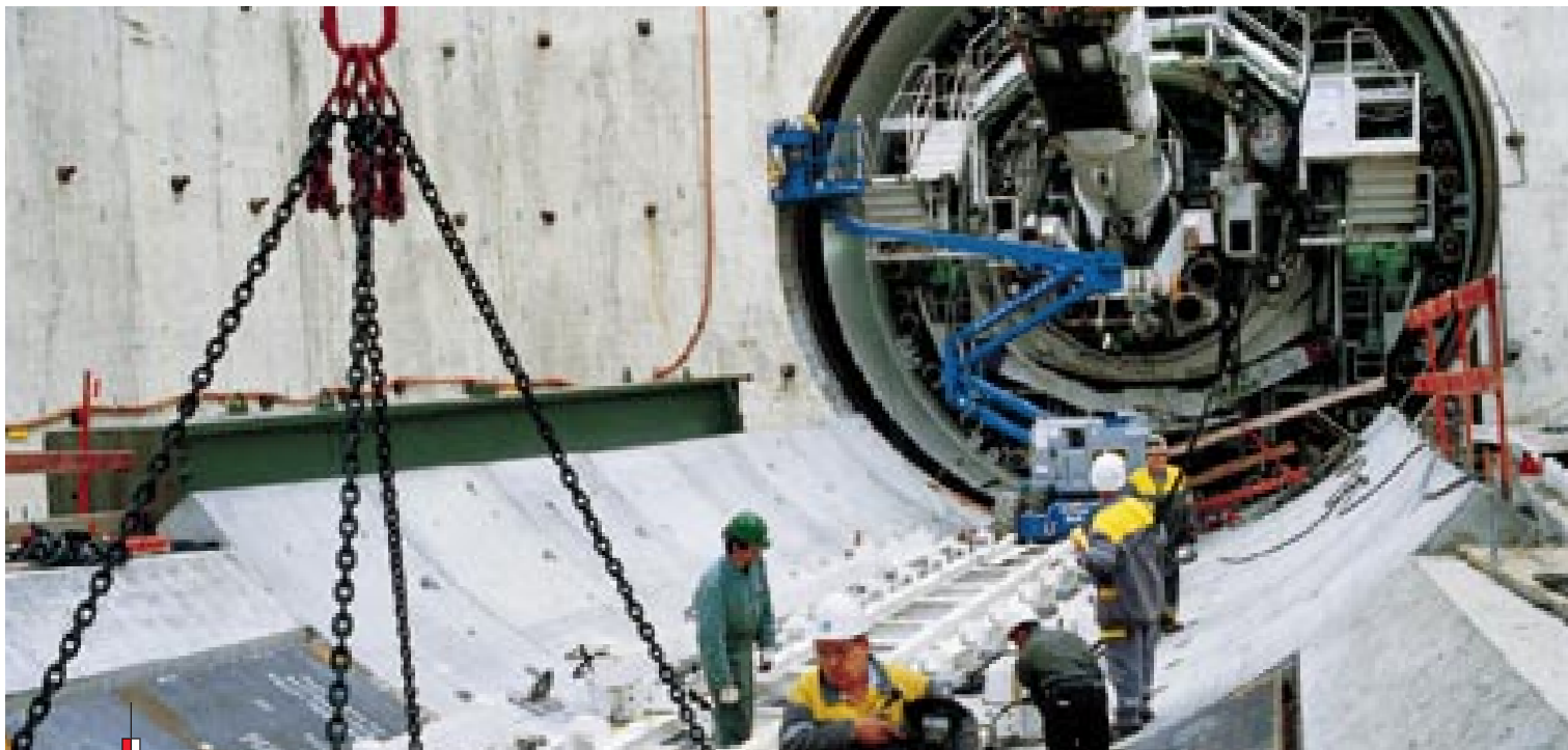
Après 2 ans d'interruption, les travaux de l'A86 à l'Ouest ont repris en février 2000 sur le site de l'échangeur de Rueil. L'assemblage du tunnelier une fois achevé, le creusement de la section Rueil-Malmaison/échangeur A13 a pu démarrer le 6 novembre 2000.
