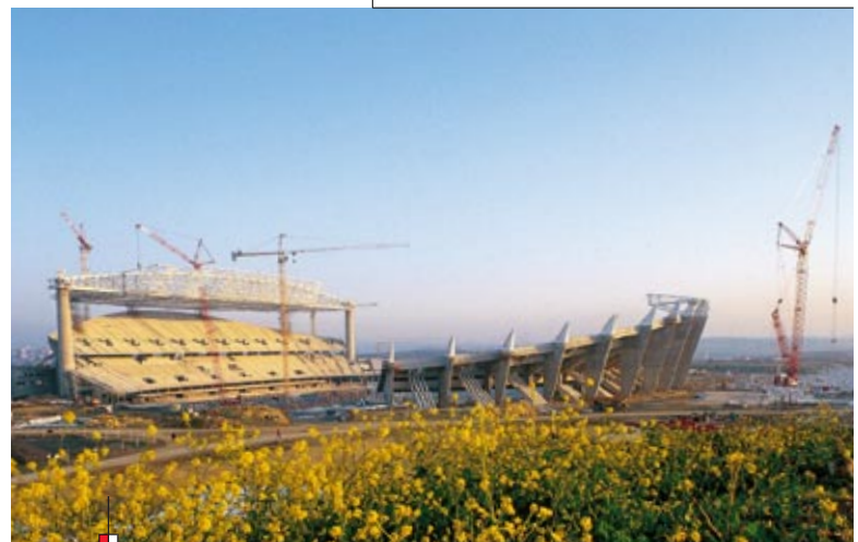
Le Stade Olympique d'Istanbul, réalisé en conception-construction, pourra dès décembre 2001 accueillir 80 000 spectateurs.
