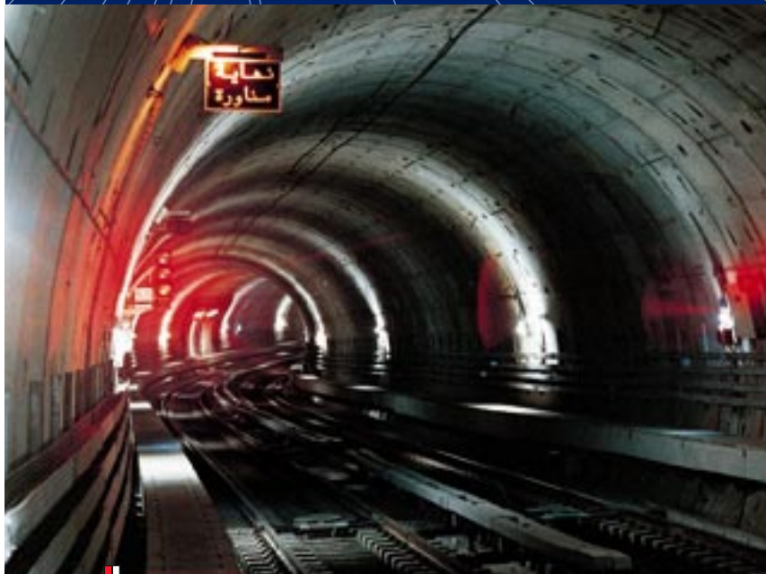
La livraison de la deuxième phase de la ligne 2 du Métro du Caire en Egypte a eu lieu en octobre 2000. Un bon exemple d'organisation et de préparation réussie d'un grand contrat de conception-construction à l'international.
