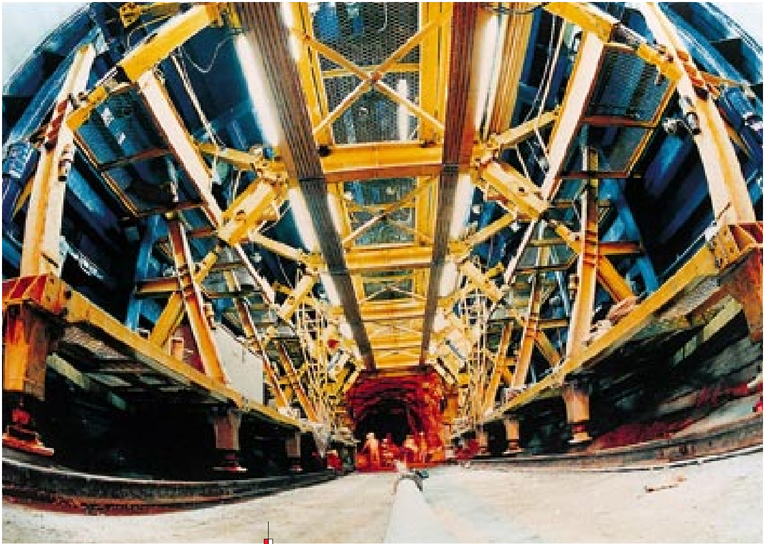
La réalisation du contrat en conception-construction du lot 603 "Black Hill Tunnels" à Hong Kong a nécessité des innovations techniques importantes, dans un esprit de partnering avec le client.
