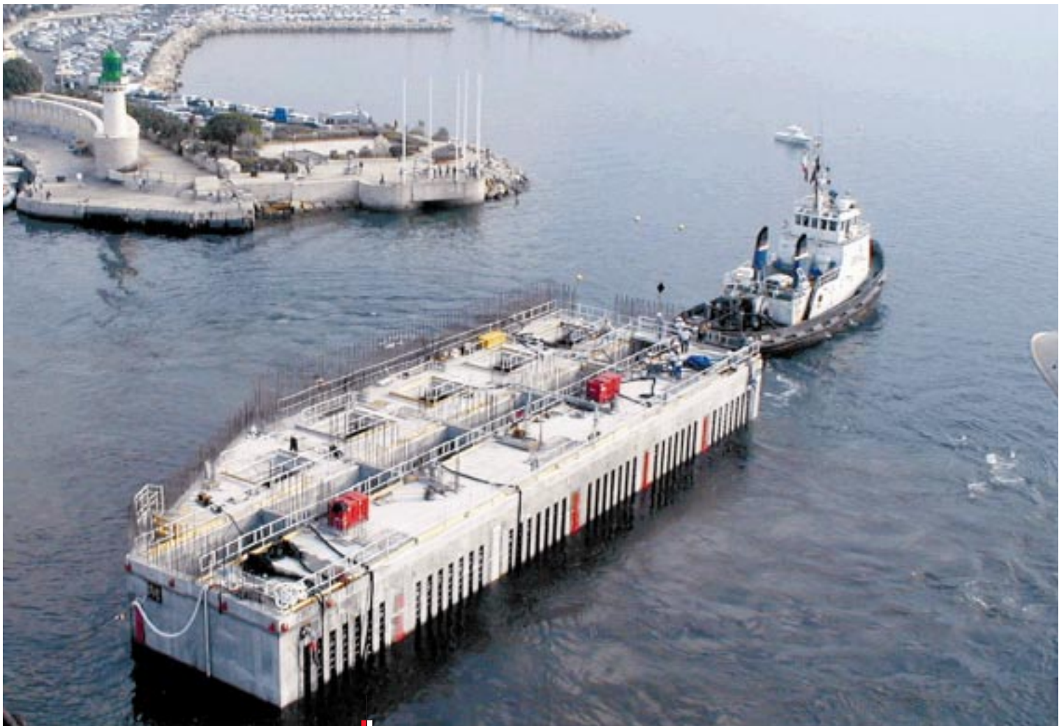
La conception-construction du terre-plein d'un hectare dans le cadre de l'extension du port de La Condamine à Monaco nécessite la réalisation exceptionnelle de 6 caissons en béton armé, pesant entre 15 000 et 35 000 tonnes.
