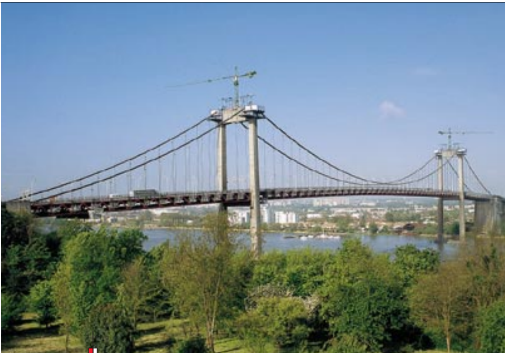
Le contrat de rénovation du pont d'Aquitaine porte sur le remplacement de la suspension existante, sous circulation, et l'élargissement de l'ouvrage afin de le faire passer à terme à deux fois trois voies. Le chantier devrait être achevé à la fin de l'année 2002.
