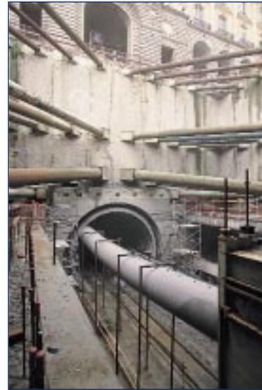
*Les travaux de confortement de terrain sur le tracé du métro de Rennes ont permis de franchir sans encombre la Vilaine, en passant sous le pont d'Orléans.*
