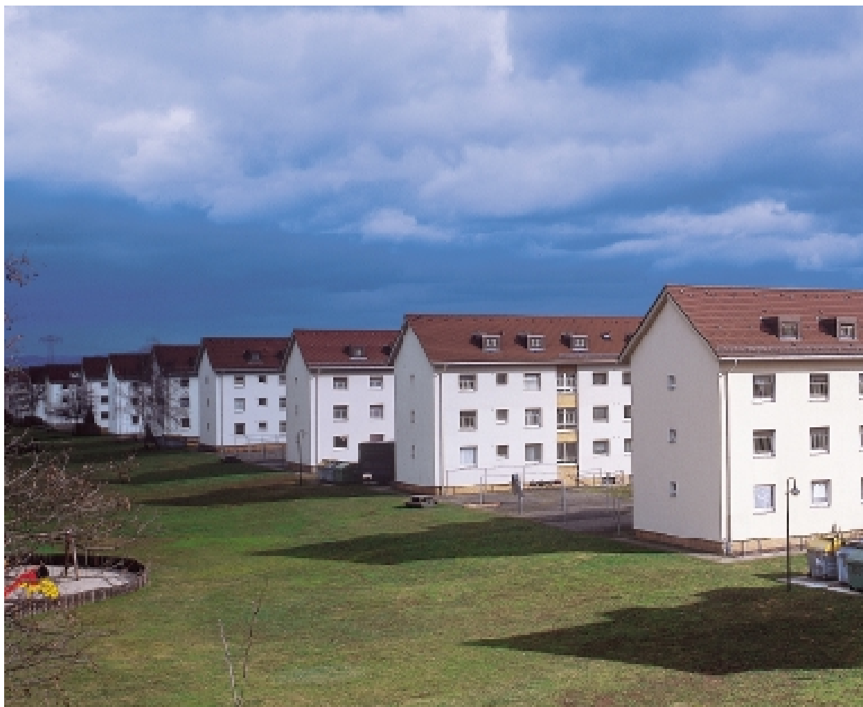
Le contrat d'entretien et de maintenance des installations de la 10 e Région militaire de l'US Army porte sur 10 bases situées autour de Francfort, soit 2 800 immeubles hébergeant 80 000 personnes.
