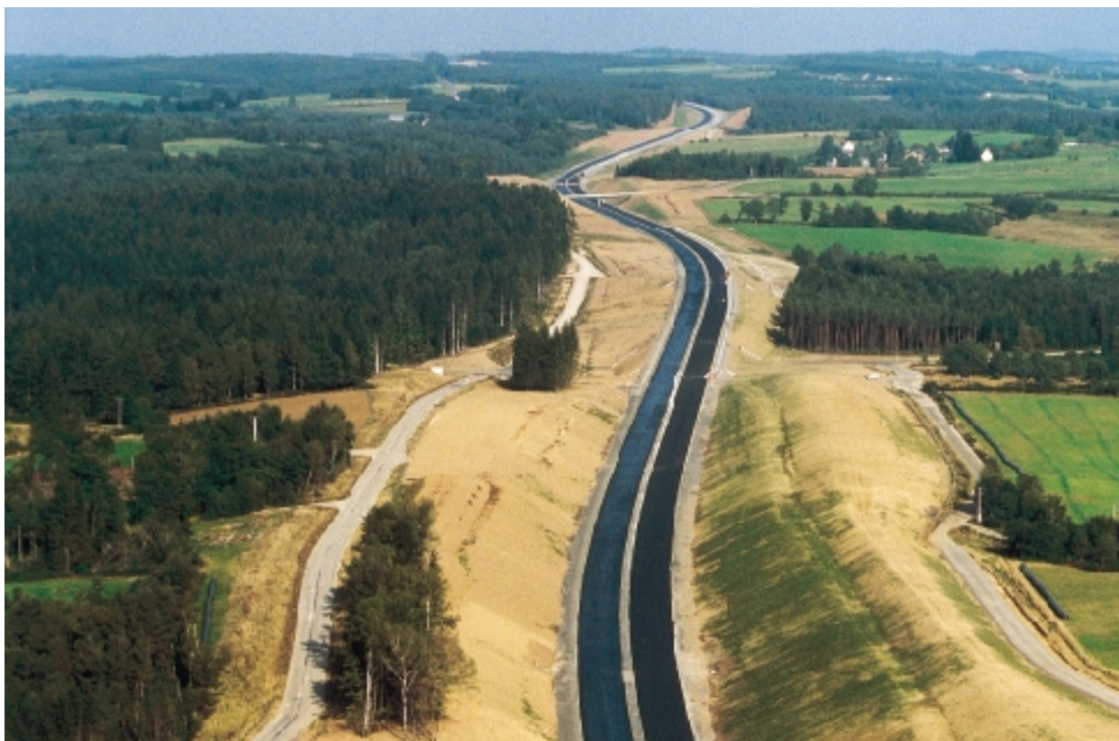
L'autoroute A89, Clermont-Ferrand - Brive, traverse les reliefs corréziens. 6,5 millions de mètres cubes de terre ont été déplacés sur le chantier.
