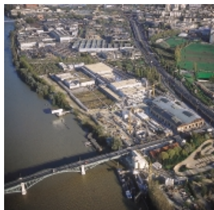
La station d'épuration de Colombes, livrée le 2 novembre, a une capacité d'un million équivalent habitants. C'est la plus importante de la région parisienne.
