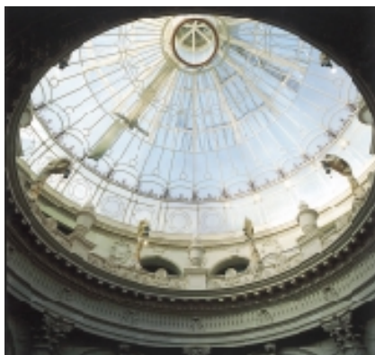
La deuxième tranche des travaux de rénovation du siège du Crédit Lyonnais à Paris, ravagé par un incendie, a été achevée en février 1999.
