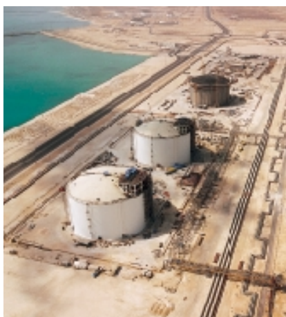
Au Qatar, les deux premiers réservoirs de 140 000 m 3 de gaz liquéfié seront achevés en mars 1999. Le troisième sera livré un an plus tard.
