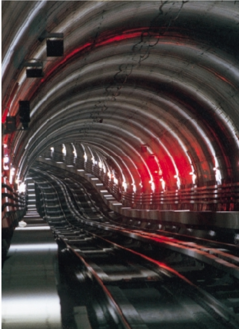
Campenon Bernard SGE est présent depuis presque 20 ans en Egypte. Après avoir réalisé les lignes 1 et 2 du métro du Caire, l'entreprise a démarré la conception et la construction de deux tunnels routiers sous le centre historique.
