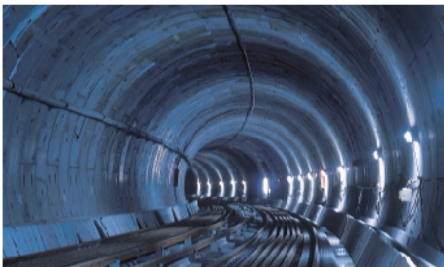
Le génie civil du métro d'Athènes s'est poursuivi sur les lignes 2 et 3, qui devraient être mises en service en 2001.
