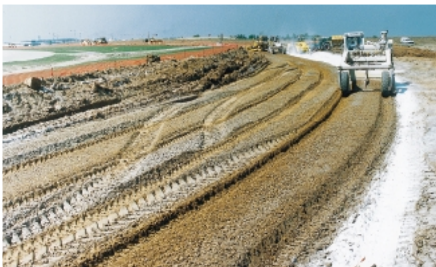
Deschiron a effectué les travaux de terrassement de la piste 4 de l'aéroport Roissy Charles-de-Gaulle. L'entreprise était précédemment intervenue sur la zone centrale, la zone de fret et la piste 2 de l'aéroport.
