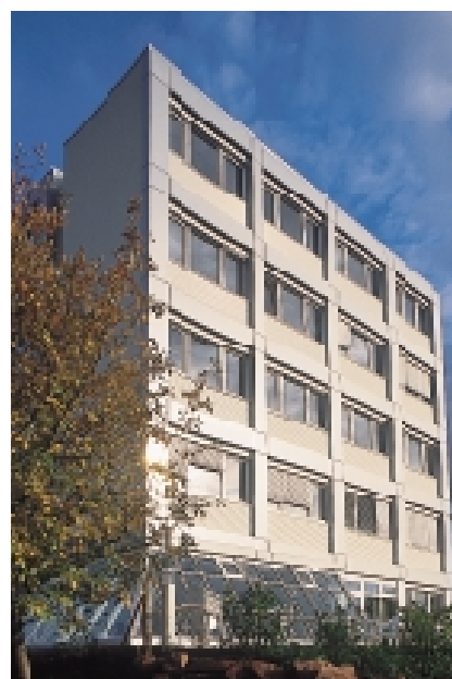
L'hôpital américain de Heidelberg en cours de rénovation.
