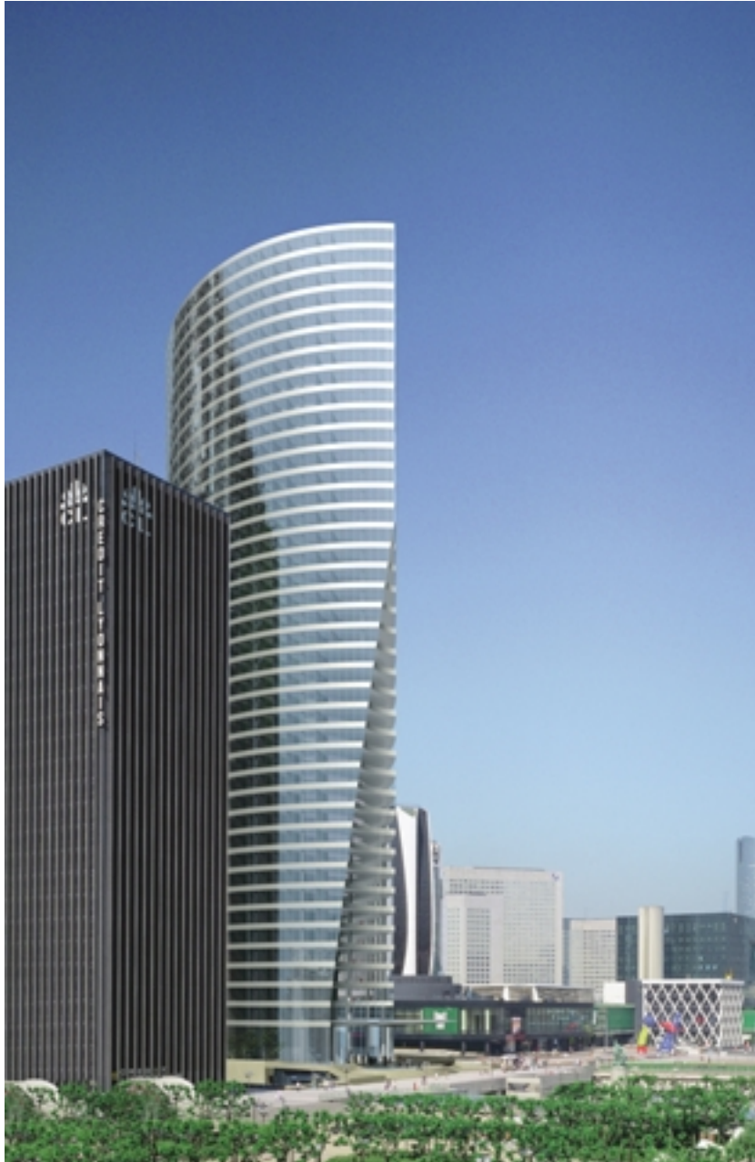
La tour PB 6, projet du promoteur américain Hines France : un nouveau contrat sur le site de la Défense où le Groupe a construit plus du tiers des immeubles de grande hauteur.
