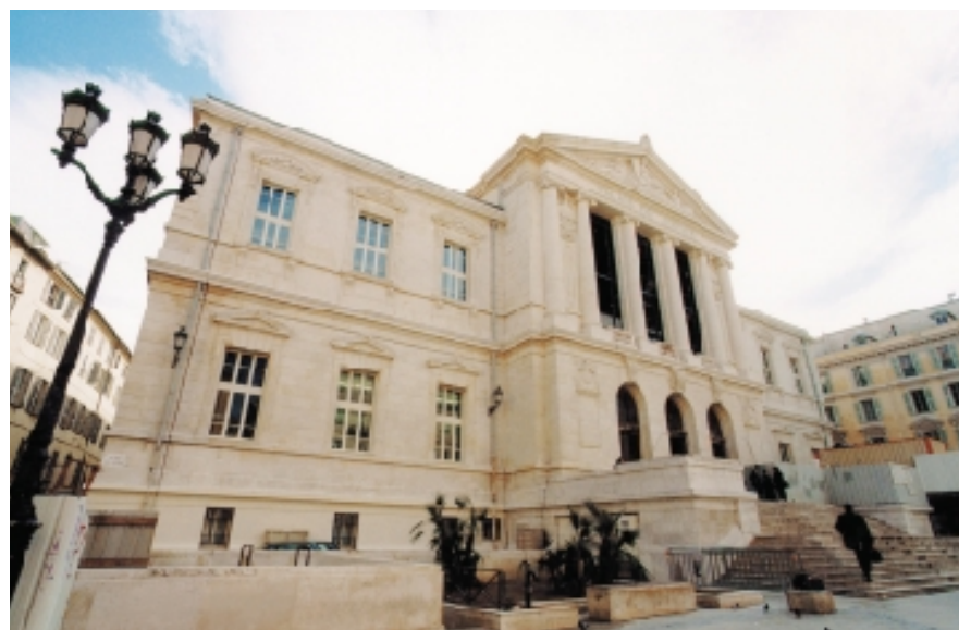
Les travaux de rénovation extérieure et intérieure du Palais de justice de Nice sont effectués sans perturber l'activité du tribunal.
