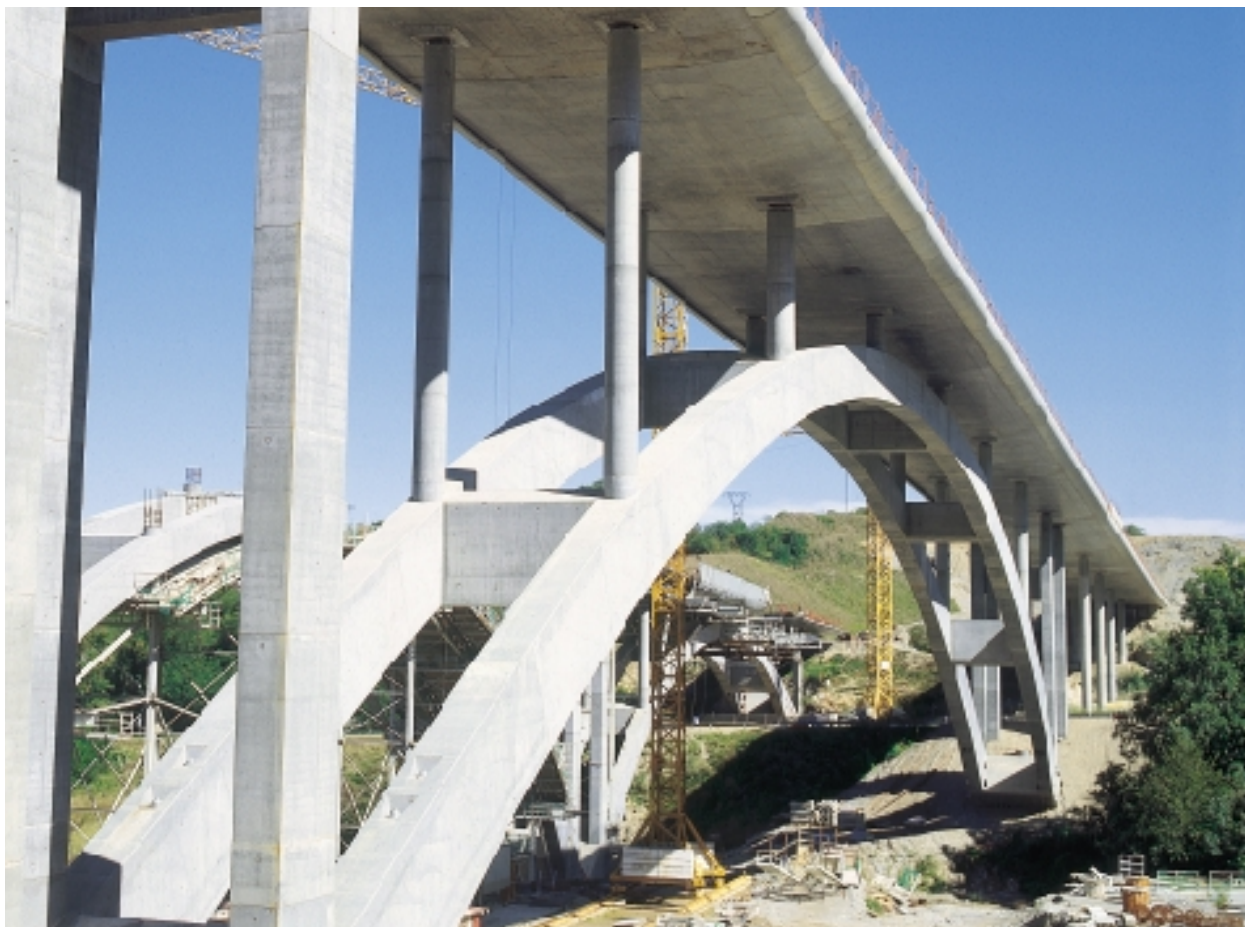
Le viaduc qui franchit la vallée du Crozet sur la future autoroute A51 Grenoble - Sisteron comprend deux ouvrages en arc.
