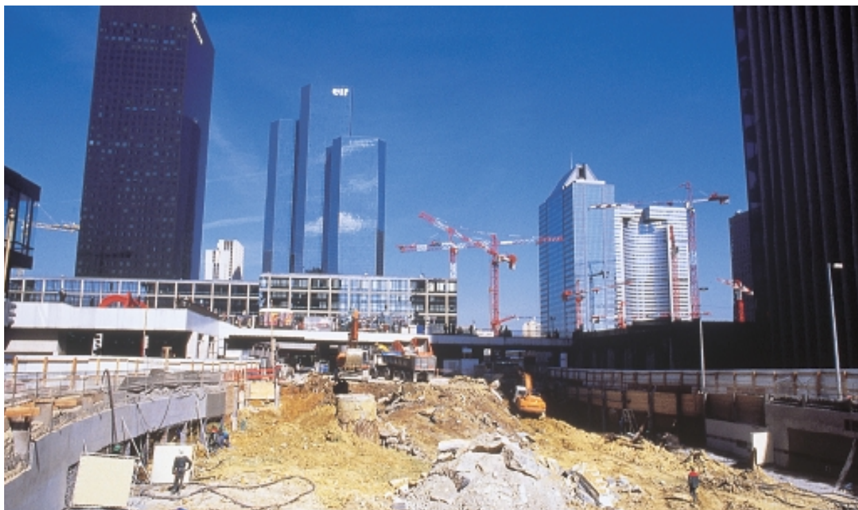
Les fondations spéciales de la Tour Hines, réalisées par Botte Sade Fondations, ont été creusées en tenant compte du tracé du futur métro Orbital.
