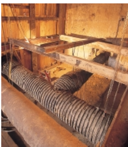
Fin avril, Par.En.Ge a entamé les travaux de béton du collecteur d'eaux usées qui longe le quai Panhard Levassor dans le 13 ème arrondissement de Paris. Long de 450 mètres, il a pour fonction de viabiliser le terrain sur lequel est prévu un vaste programme immobilier.
