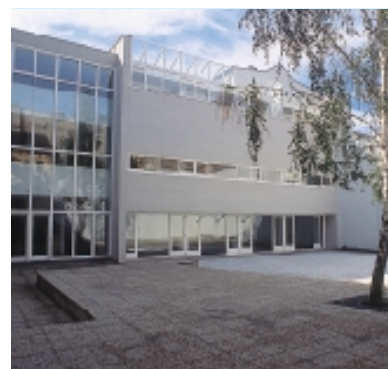
Rénovation et extension du lycée français de Prague (architectes Brante & Wollen-Weider).
