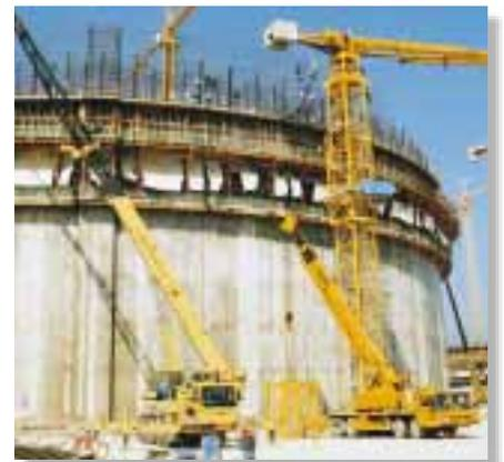
Le voile extérieur d'un des trois réservoirs de gaz au Qatar.
