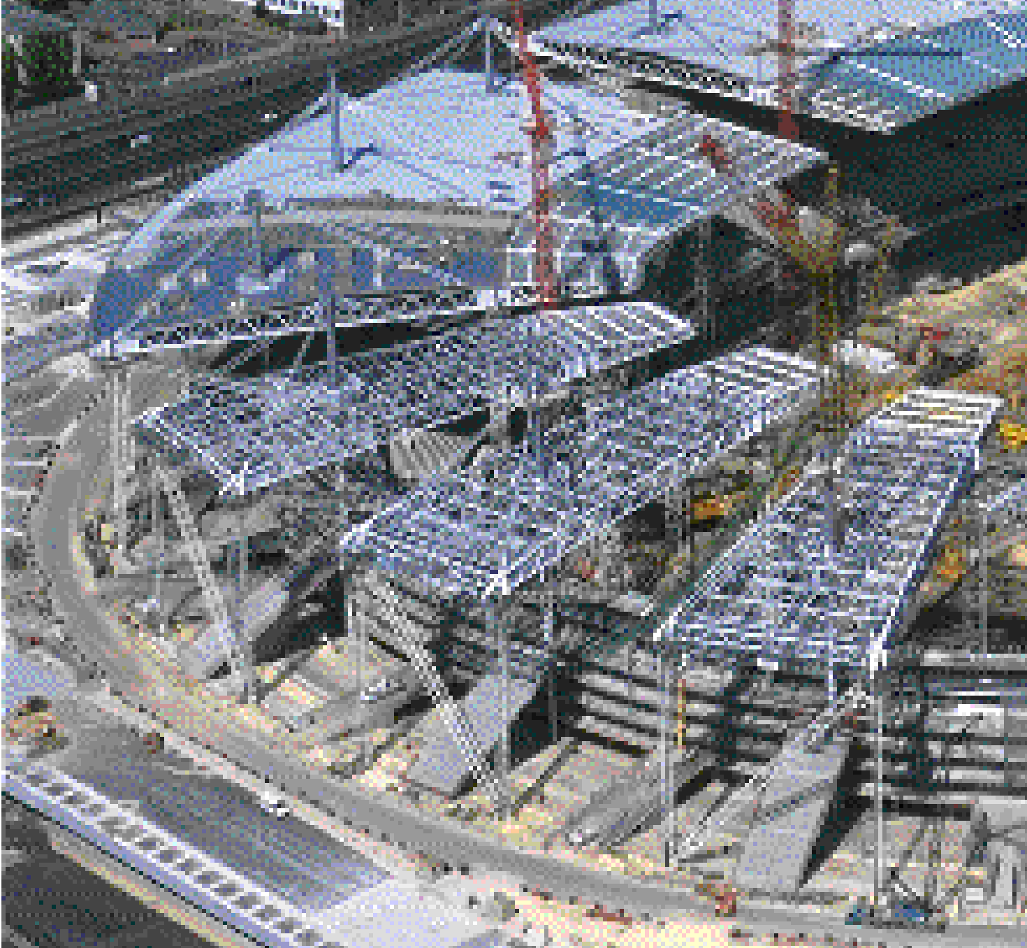
Das Dach des Stade de France wird 42 m über dem Rasen von 18 Nadelspitzen gehalten.
