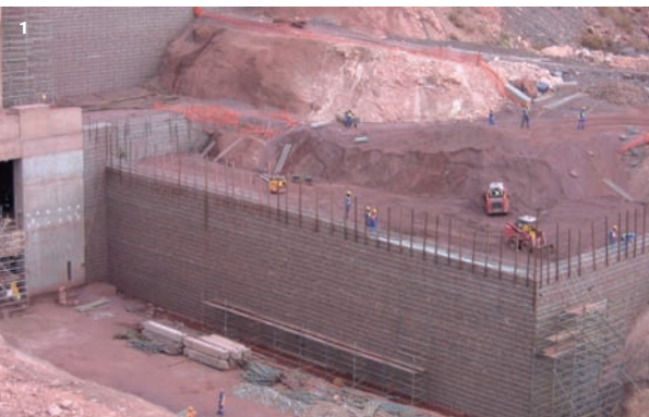
1) Sur le site de la mine de Sishen (Afrique du Sud), Reinforced Earth a combiné les techniques TerraNail (terre composite ancrée permettant de construire un ouvrage en sol renforcé de grande hauteur adossé à une pente existante ne laissant que 2 m d'espacement à la base) et TerraTrel pour édifier un mur de grande hauteur (14 m).
