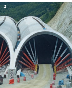
2) En Corée du Sud, les premières voûtes TechSpan réalisées par Freyssinet Korea totalisent une longueur de plus de 2 000 m.
