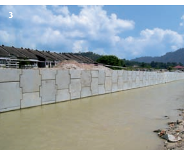
3) En Malaisie, Reinforced Earth a mis en œuvre son système innovant de connexion synthétique Omega sur deux murs de soutènement des rives d'un cours d'eau dans la banlieue de Kuala Lumpur.
