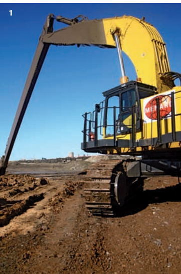
1) En Nouvelle-Galles du Sud (Australie), Austress Menard a réalisé une barrière de protection en sol-bentonite pour empêcher les agents polluants contenus dans le sol d'un ancien site sidérurgique de contaminer le fleuve Hunter.
