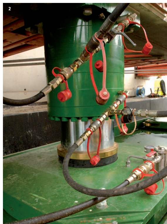
2) Initialement développé par Hebetec pour déplacer les navires sur les chantiers navals de Corée du Sud, le système à coussin d'air APS a permis de ripper le tablier d'un pont ferroviaire en Seine-Maritime au cours de l'été 2006.
