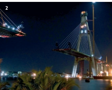
2) En Thaïlande, Freyssinet réalise le haubannage de la travée centrale, longue de 500 m, du pont de Sobrr.
