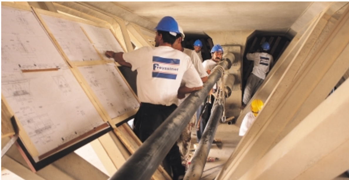
Intérieur du tablier du pont de Bubiyan, au Koweït.
