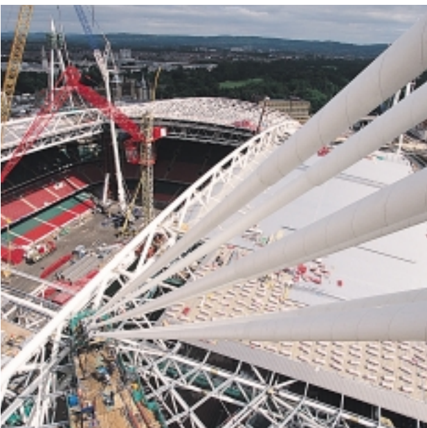
La couverture du Millennium Stadium de Cardiff (Grande-Bretagne), construit à l'occasion de la Coupe du monde de rugby, est supportée par quatre mâts de 80 m de haut soutenus chacun par 18 haubans.
