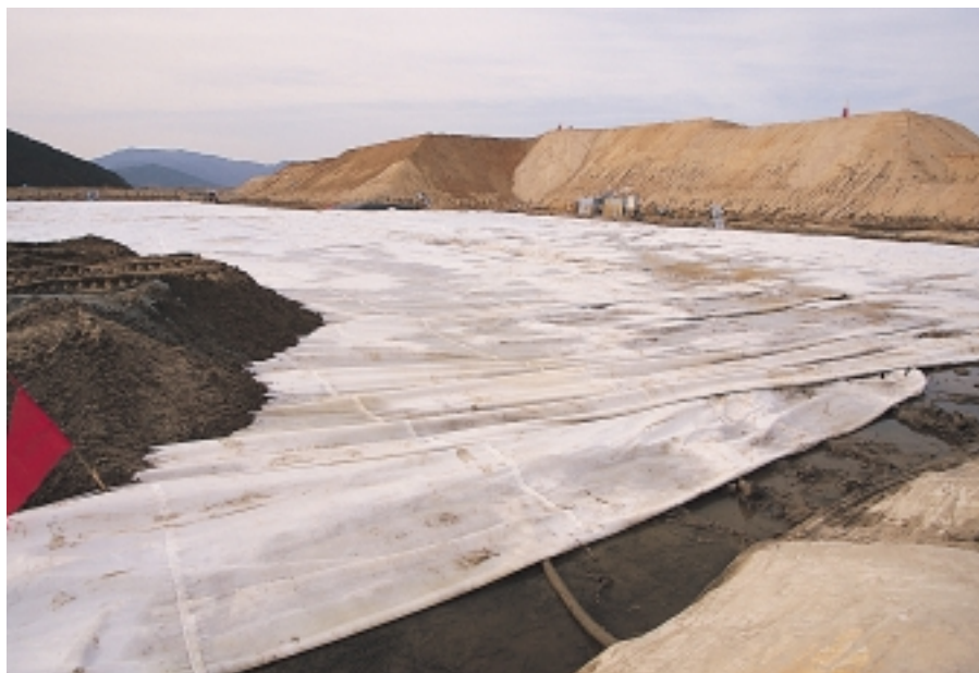
Le terrain de la future station d'épuration de Jangyoo , en Corée du Sud, traité selon le procédé Ménard Vacuum®. Une membrane posée sur le sol, associée à un système de pompes, permet de créer le vide et de consolider ainsi le terrain. Le tassement prévu est de 6 m, soit la hauteur d'un immeuble de deux étages.
