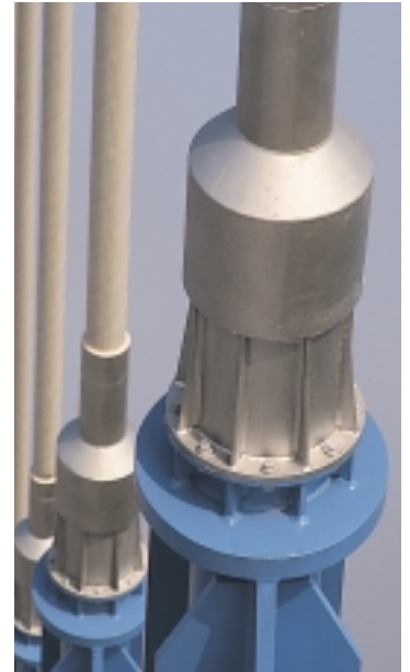
Ancrage inférieur de hauban.
