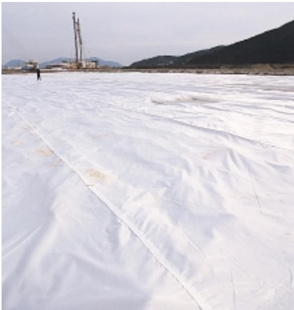
Renforcement de sol sur le site de la station d'épuration de Jangyoo, en Corée du Sud, selon le procédé Ménard Vacuum®.
