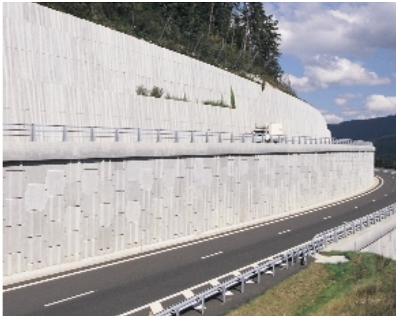
Mur de soutènement : l'une des applications du savoir-faire de Freyssinet dans le domaine des sols.
