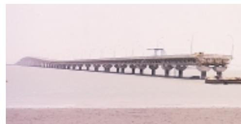
Pont de Bubiyan, au Koweït. Freyssinet assure la reconstruction des travées détruites lors de la guerre du Golfe.
