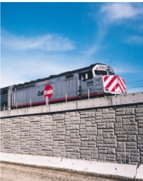
Réaménagement ferroviaire de Ralston Holly Grade, au sud de San Francisco. 55 000 m 2 de murs de soutènement ont été réalisés dans le cadre de ce projet.
