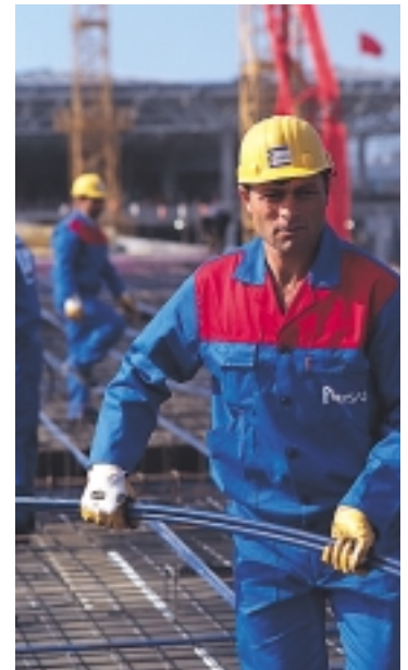
Précontrainte de planchers pour l'aéroport Atatürk, le plus grand chantier de construction en cours en Turquie.
