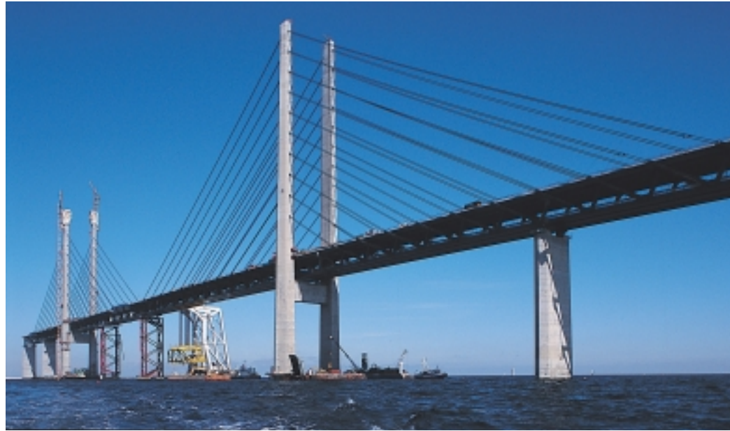
160 haubans , soit 2 300 t d'acier, ont été mis en œuvre par Freyssinet sur le pont d'Øresund - un ouvrage d'une ampleur exceptionnelle.
