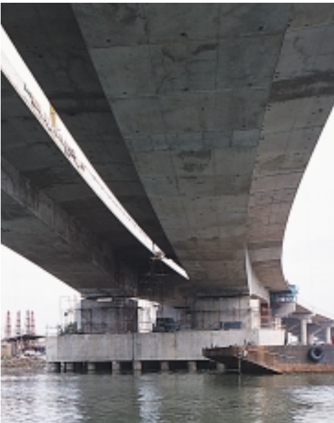
Pont autoroutier sur le Lek, aux Pays-Bas, où 1 000 t de câbles de précontrainte ont été mis en œuvre.
