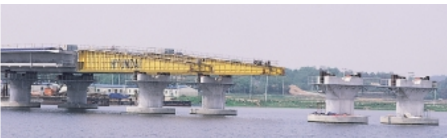
Viaduc de Roquemaure , dans le département français du Gard (en haut), sur la nouvelle ligne TGV-Méditerranée.
