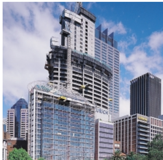
À Sydney, en Australie , Freyssinet assure la précontrainte par post-tension de deux tours de plus de 40 étages.
