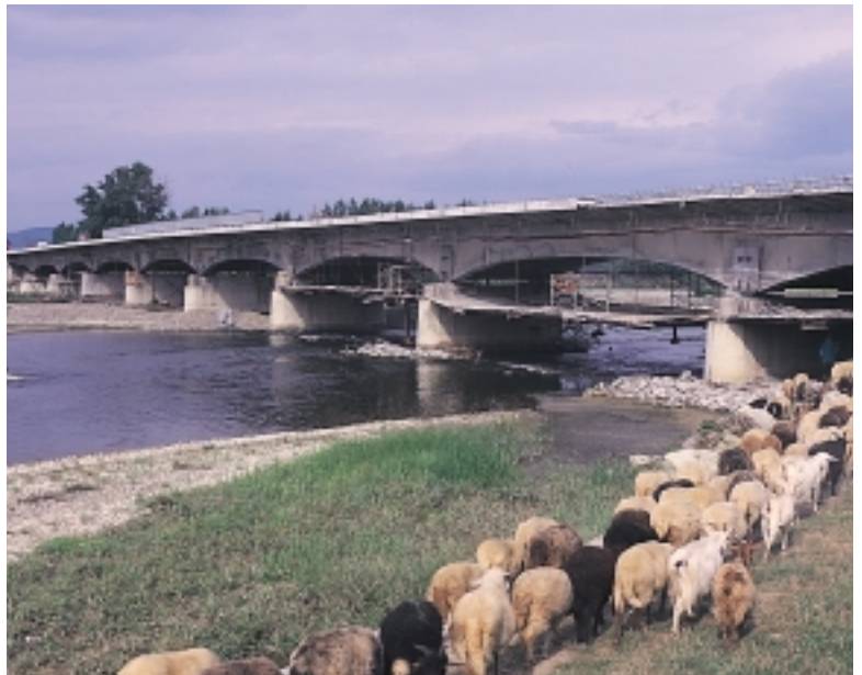
En Roumanie, Freyssinet participe à la réparation d'une dizaine d'ouvrages d'art sur les principaux axes routiers du pays.
