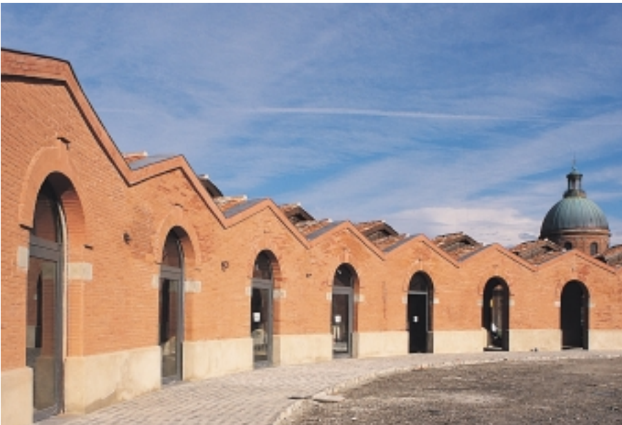
L'Espace d'art moderne et contemporain de Toulouse (France) est construit sur le site des anciens abattoirs de la ville. Freyssinet a renforcé 12 arcs en briques datant de 1830.
