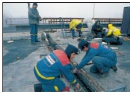
PONT DE PLOIESTI (ROUMANIE)
