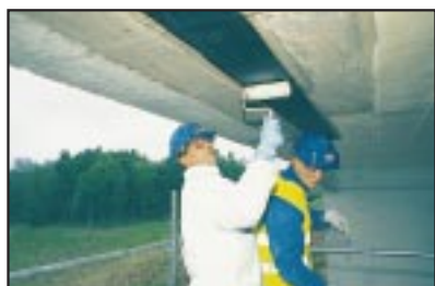
ECHANGEUR D'AVALLON (FRANCE)
