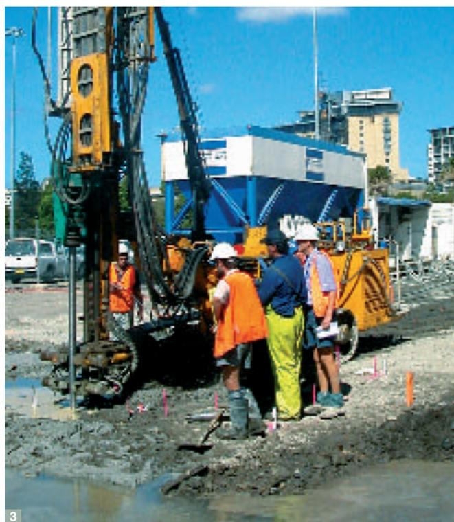
**3** Austress Freyssinet a consolidé des sols sur Darling Island, en plein cœur de Sydney, par mise en œuvre de colonnes de *jet-grouting* Freyssimix.
