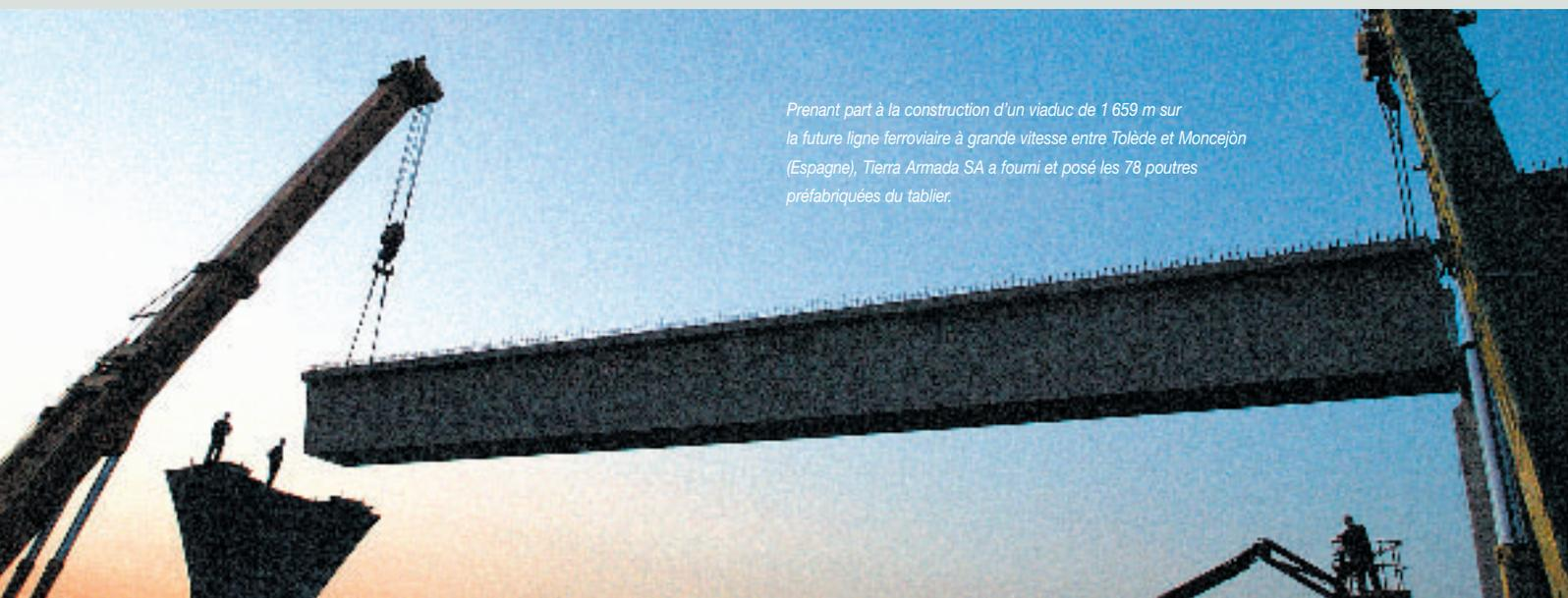
*Prenant part à la construction d'un viaduc de 1 659 m sur la future ligne ferroviaire à grande vitesse entre Tolède et Moncejòn (Espagne), Tierra Armada SA a fourni et posé les 78 poutres préfabriquées du tablier.*
