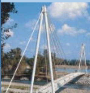
Passerelle de Laroin (France).
