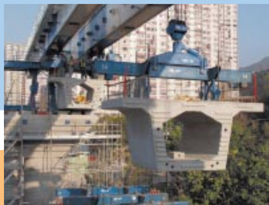
VIADUCS D'EAST RAIL (Hong-Kong)
