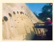
original de 200 m de long, construit à Adélaïde avec des éléments préfabriqués de 5 m de haut et 2,5 m de large, pour permettre l'évacuation des eaux de la lagune de Patawallonga vers l'océan.
