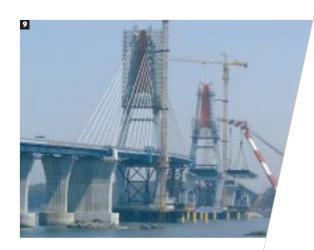
Au nord-ouest de Séoul, en Corée du Sud, le pont de Young Hung a été clavé au début du mois de juin. L'ouvrage mesure 500 m de longueur, une travée centrale haubanée de 250 m. Le tablier métallique est suspendu par 64 haubans Freyssinet variant de 25HD15 à 55HD15, répartis en deux nappes symétriques.
