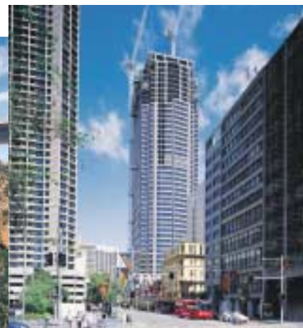
Australie , achèvement des travaux de l'immeuble Park Plaza à Sydney.
