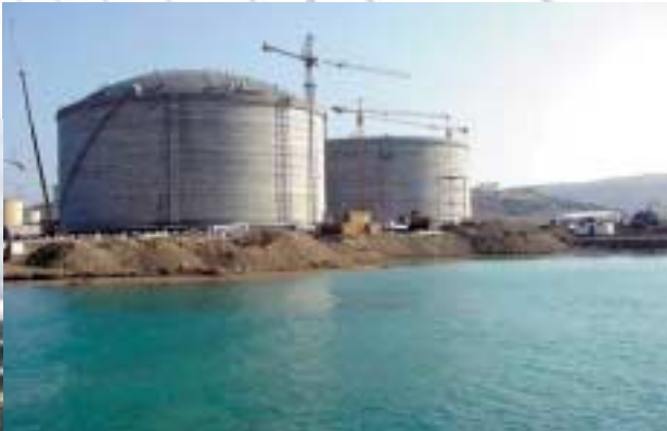
Turquie , complexe de stockage de GNL à Aliaga.
