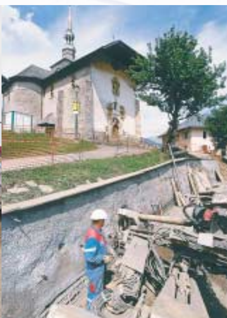
France , confortement de Saint-Nicolas-la-Chapelle.
