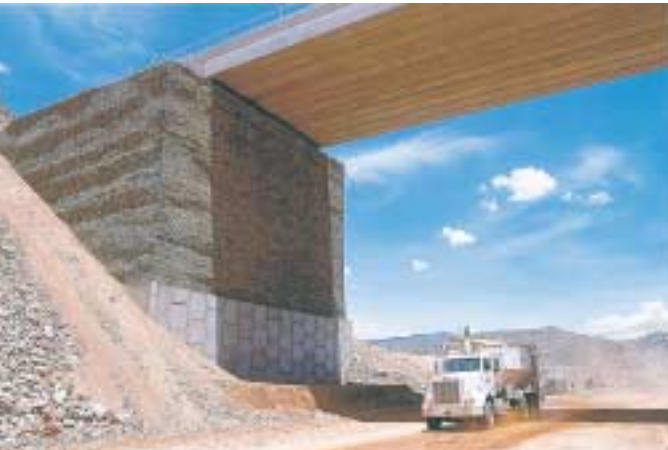
États-Unis , culée de pont routier pour la mine de Moranci.
