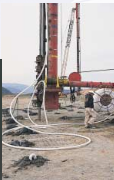
Corée , chantier de la station de traitement des eaux de Jangyoo.
