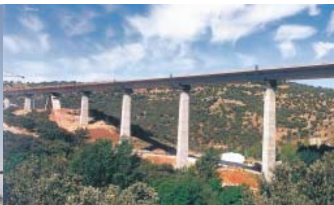
Espagne , réalisation de la liaison ferroviaire à grande vitesse entre Madrid et Barcelone.
