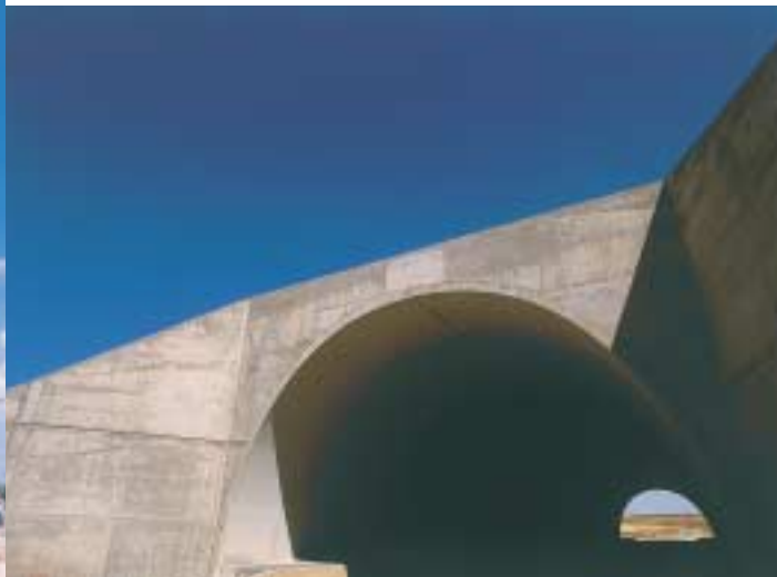
Espagne , voûte TechSpan® de Torremocha, sur le tracé de l'AVE.
