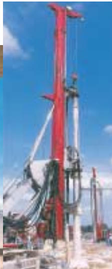
France , travaux pour la STEP de Reims.
