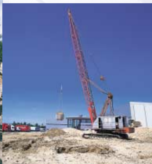
France , travaux de la ZAC Paris Oise à Longueil.
