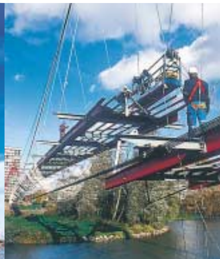
France , passerelle des Deux Lions à Tours.
