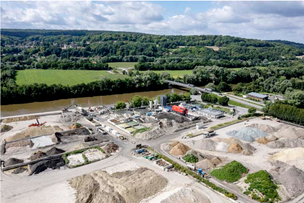
Bruyères-sur-Oise (95) Plate-forme de valorisation
